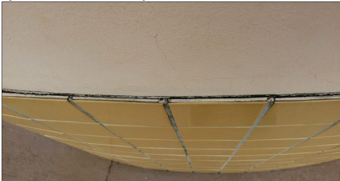
Figura 25 – Pastilhas cerâmicas com empolamento.
