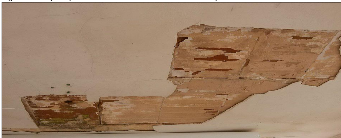
Figura 24 – Aplicação de massa corrida diretamente sobre lajotas cerâmicas.
