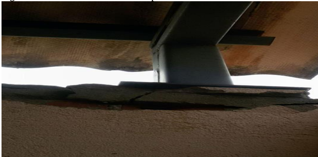
Figura 26 – Pilar da tesoura metálica apoiada diretamente sobre alvenaria.
