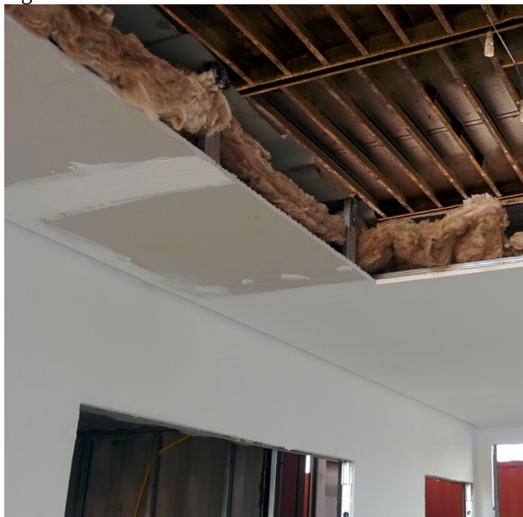
Figura 09 – Container com isolamento e revestimento.
