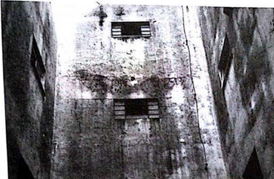
Figura 7 - Revestimento em argamassa.
