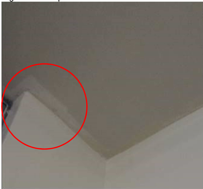
Figura 26 - Repintura do teto em uma sala de aula.
