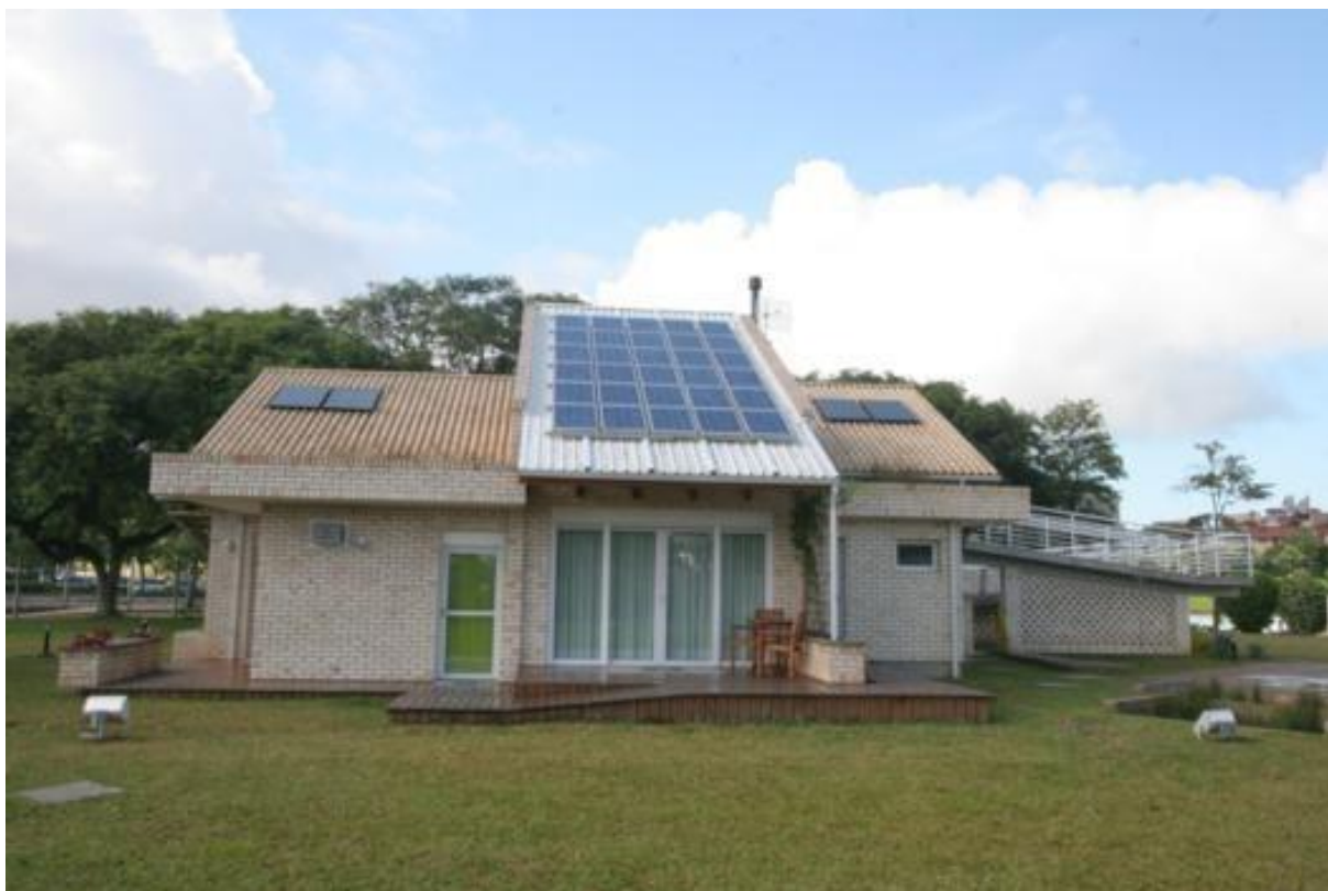
Figura 01: Residência com painéis fotovoltaicos instalados em sua cobertura em Florianópolis - SC.
