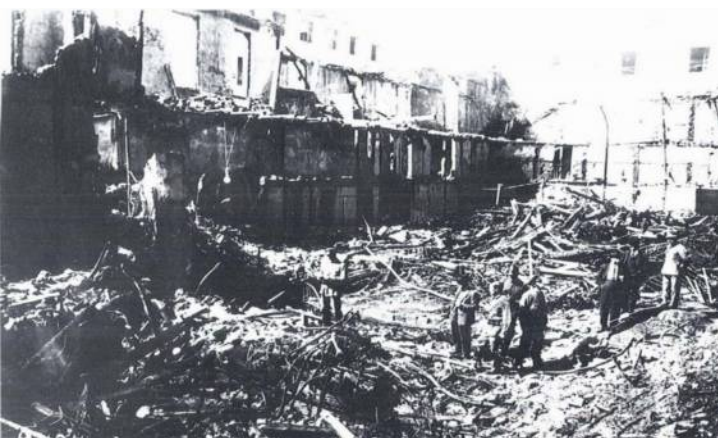
Figura 02 - Incêndio Teatro Iroquois
