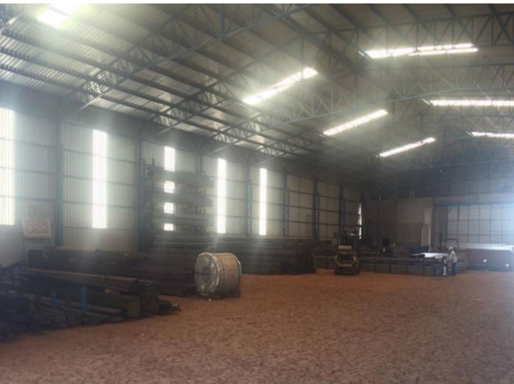
Figura 13 - Estoque de aço
