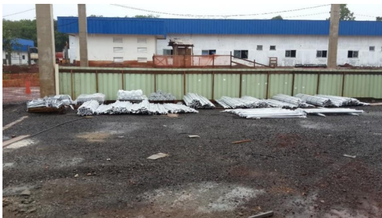
Figura 42 - Material descarregado no canteiro de obras
