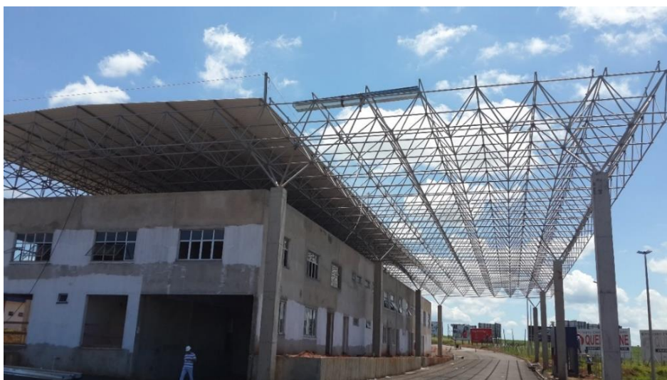
Figura 49 - Colocação das telhas da cobertura
