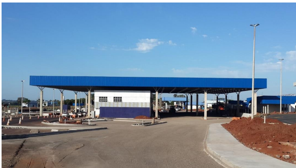
Figura 51 - Fachada da edificação finalizada.
