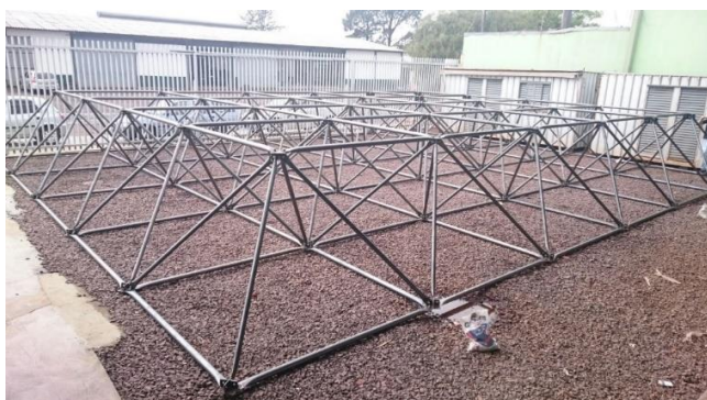
Figura 10 - Exemplo de treliça quadrado sobre quadrado com defasagem de meio módulo
