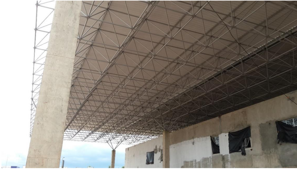
Figura 55 - Vista inferior da estrutura metálica espacial
