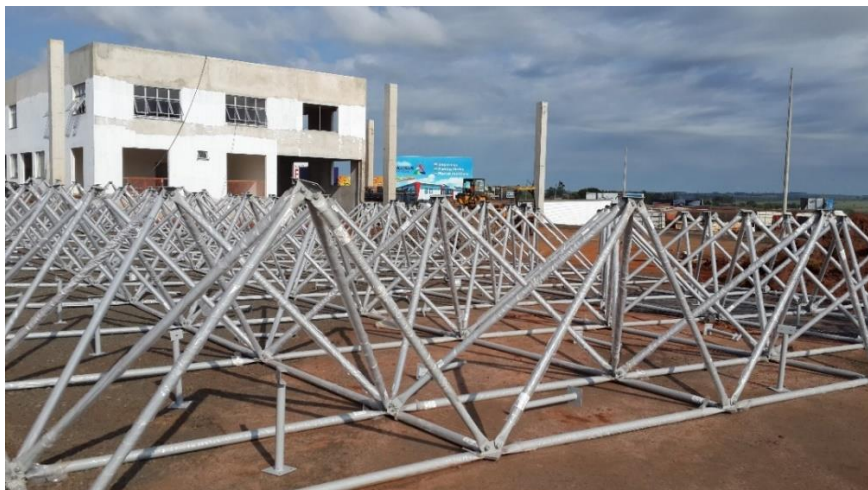
Figura 44 - Diagonais ligadas pelos “nós” inferiores e superiores
