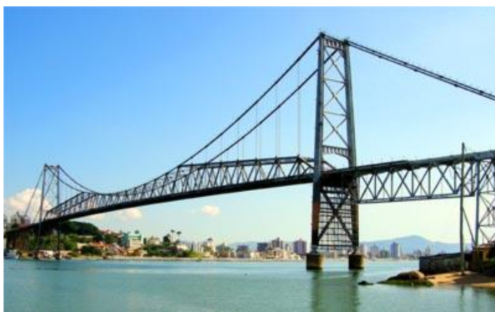
Figura 7 - Ponte Hercílio Luz
