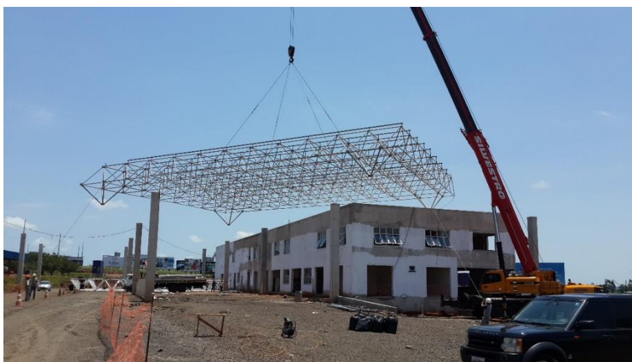
Figura 47 - Içamento do módulo 1
