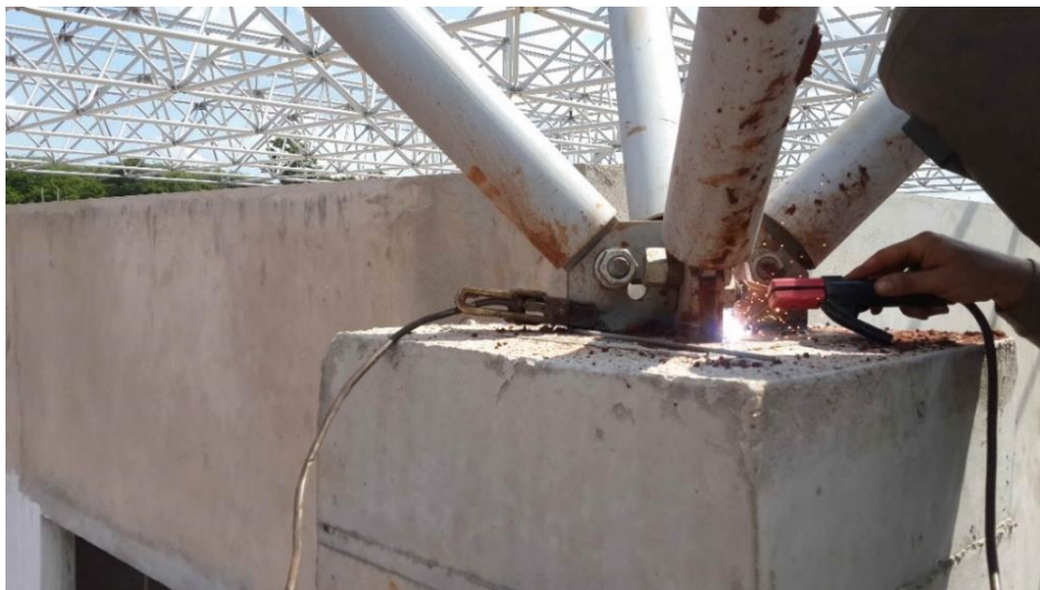
Figura 48 - Soldagem do “nó” na chapa de cabeça do pilar
