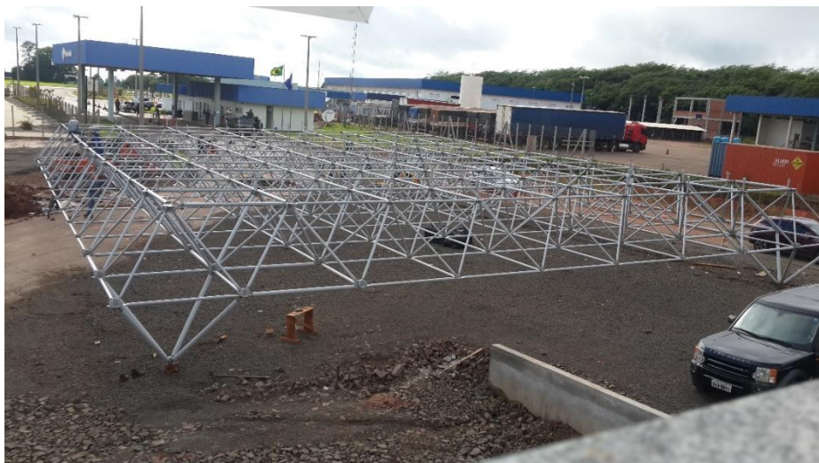
Figura 46 - Montagem do módulo 1 completa
