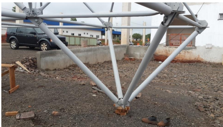
Figura 45 - “Pé de galinha” para sustentação da estrutura
