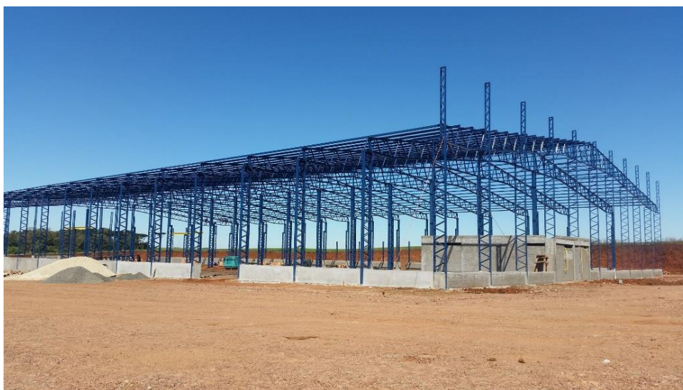
Figura 54 - Estrutura metálica convencional
