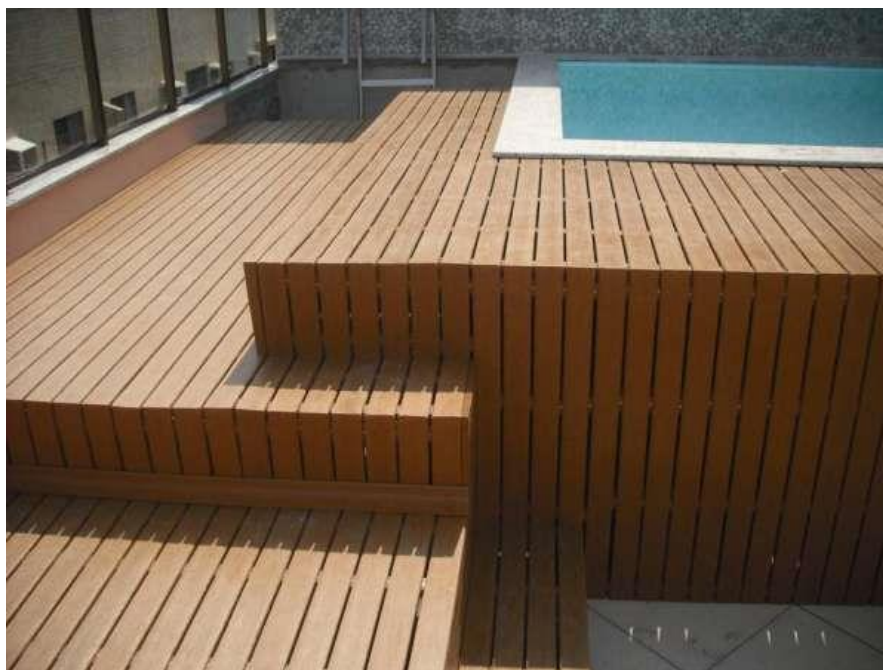
Figura 11: Madeira plástica utilizada em construção de um deck.
