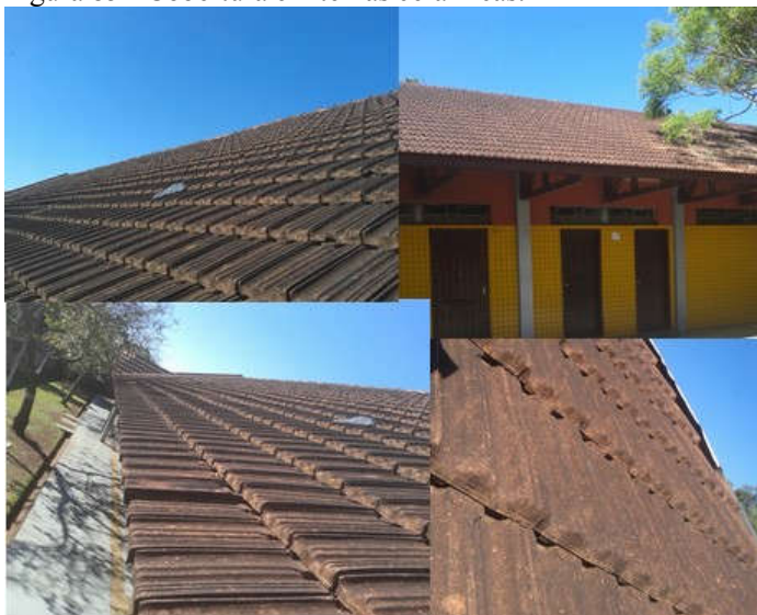
Figura 85 - Cobertura em telhas cerâmicas.
