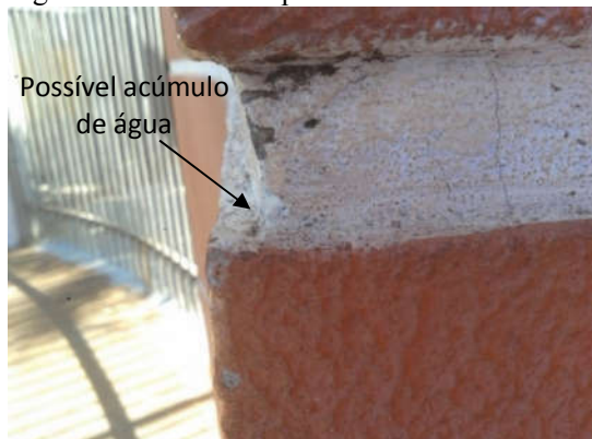
Figura 43 - Friso da superfície da alvenaria.
