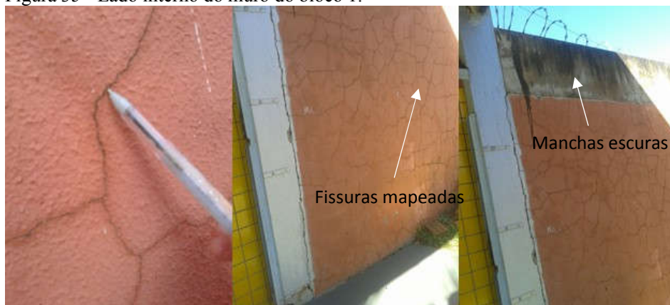
Figura 35 - Lado interno do muro do bloco 1.
