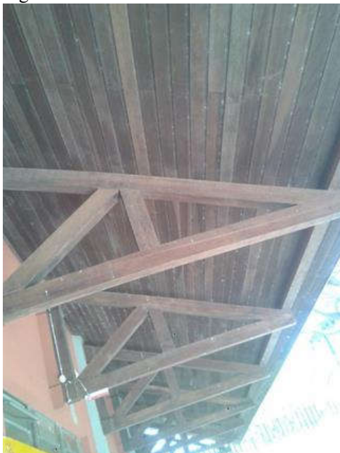
Figura 83 - Forro da cobertura do corredor do bloco 3.
