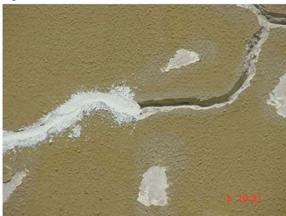
Figura 39 - Primeira demão de selante acrílico.
