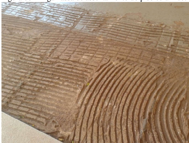
Figura 68 - Argamassa de assentamento do piso cerâmico.
