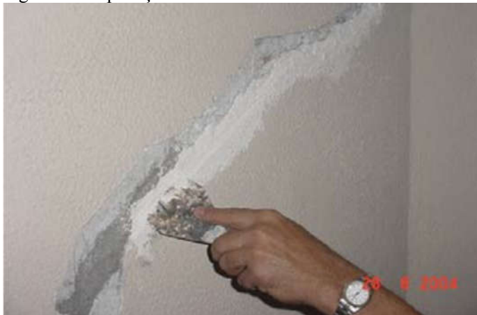
Figura 66 - Aplicação de selante acrílico com fibras de vidro.
