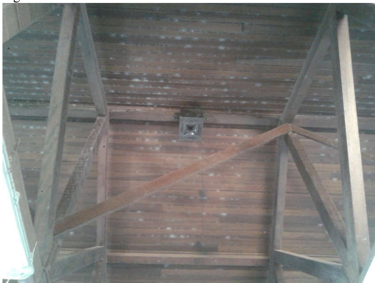
Figura 84 - Forro da cobertura do refeitório dos alunos.
