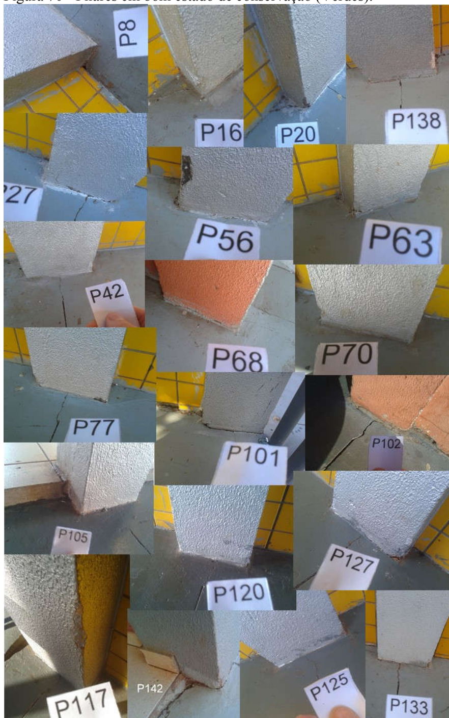
Figura 70 - Pilares em bom estado de conservação (Verdes).
