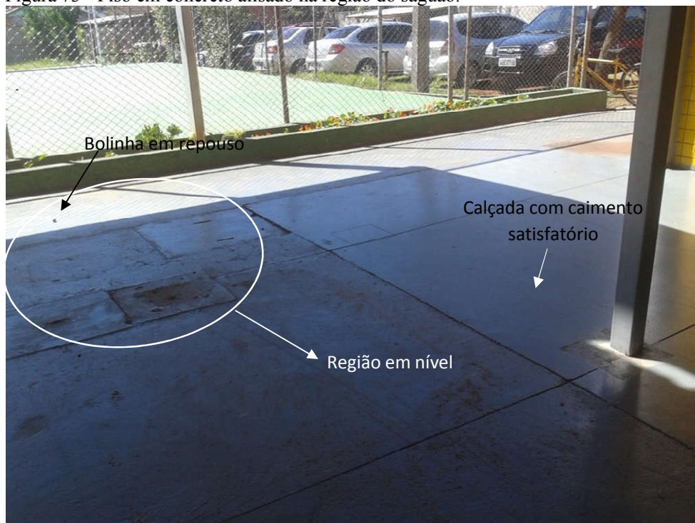
Figura 73 - Piso em concreto alisado na região do saguão.
