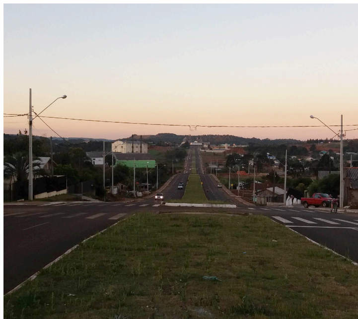
Figura 34 – Extensão da avenida nova.
