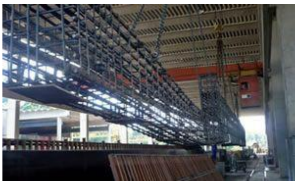
Figura 9 – Armadura sendo transportada pela ponte rolante
