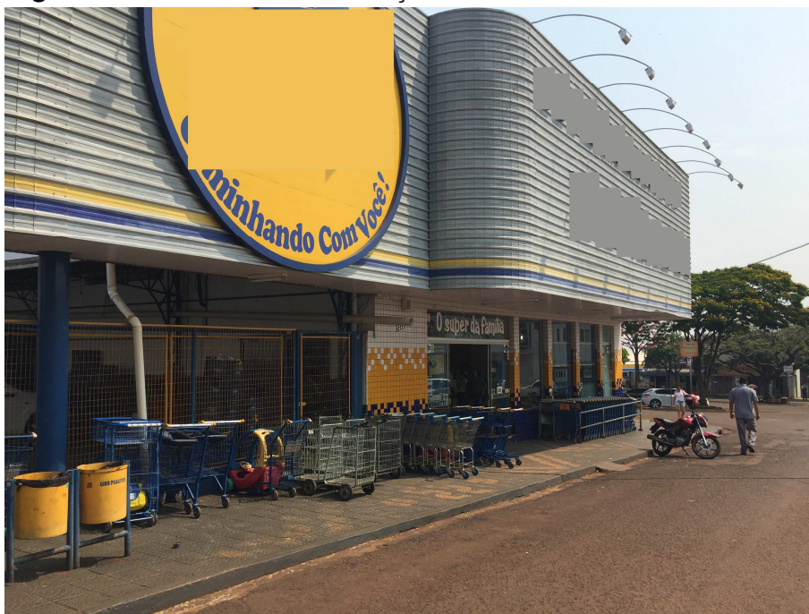
Figura 1 – Fachada da Edificação
