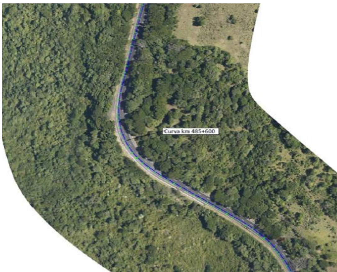
Figura 13- Foto área da curva do km 485+600
