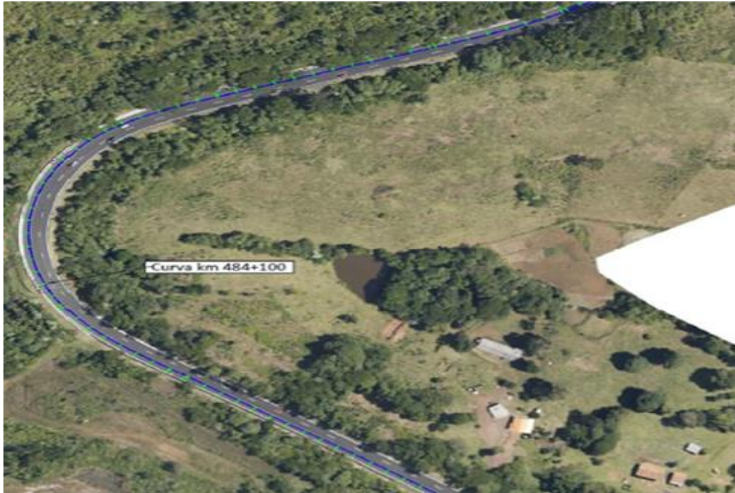
Figura 11- Foto área da curva do km 484+100
