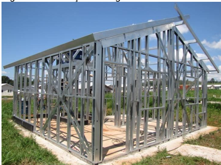
Figura 3: Edificação em Light Steel Frame .
