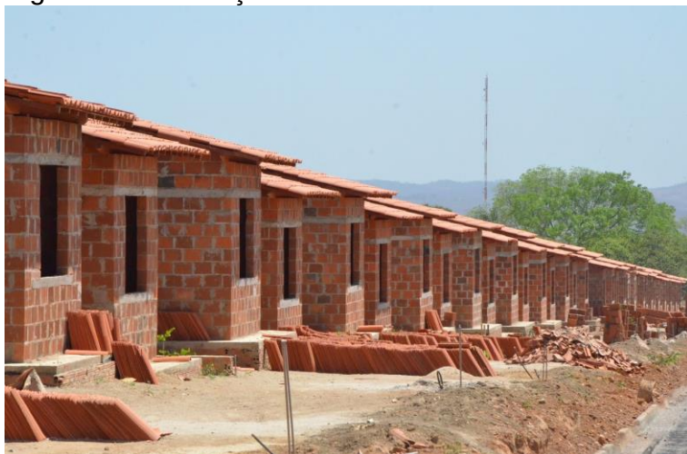
Figura 21: Edificação em alvenaria convencional.
