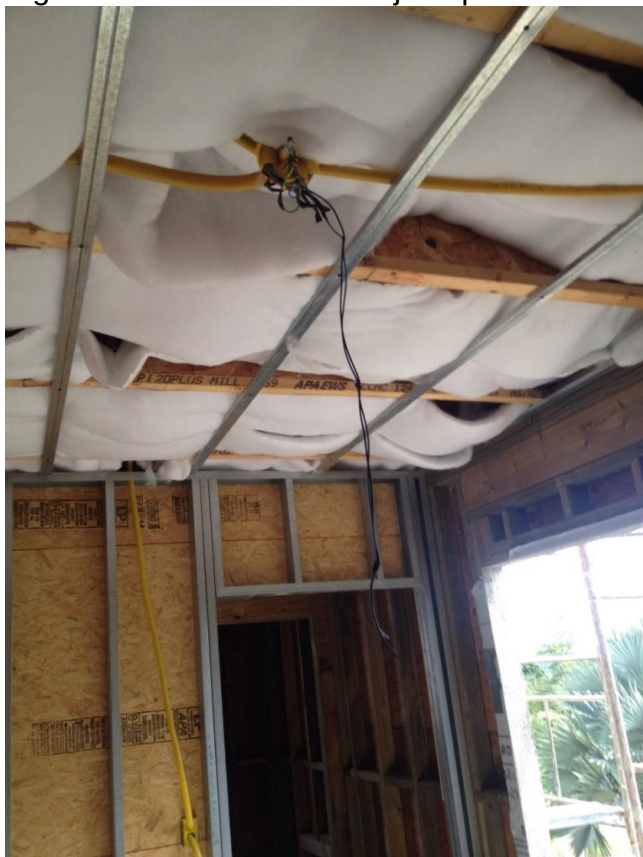
Figura 19: Isolamento da laje superior com lã de pet .
