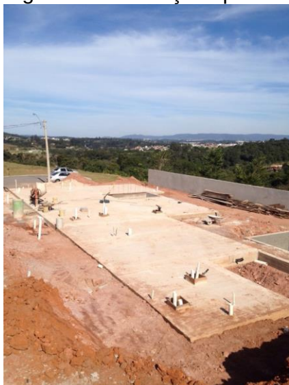
Figura 12: Fundação tipo radier .
