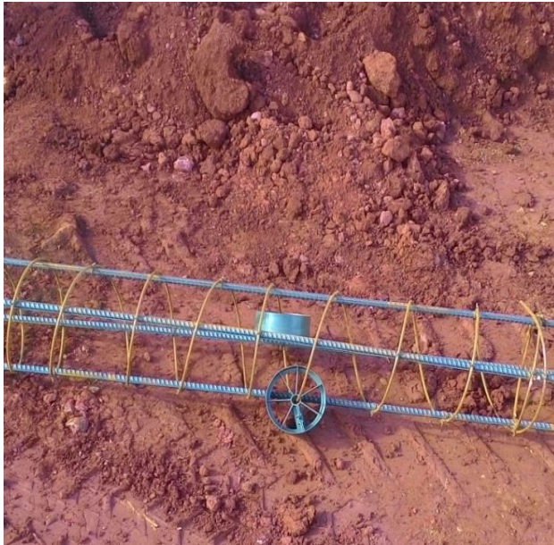
Figura 19 - Posicionamento dos espaçadores.
