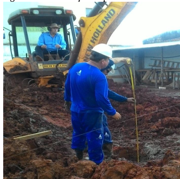
Figura 28 - Verificação da profundidade.
