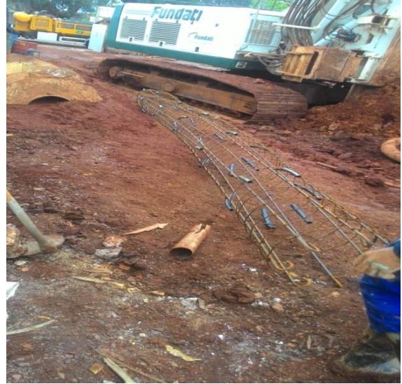
Figura 30 - Utilização de espaçadores.
