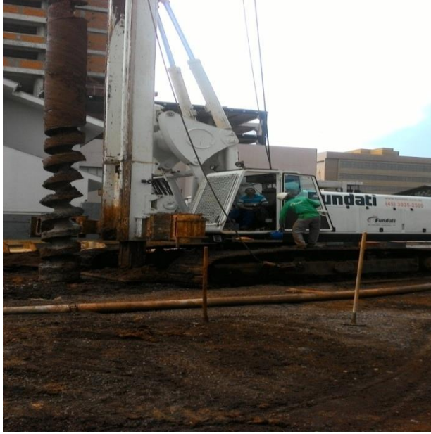
Figura 25 - Hélice Contínua Monitorada.
