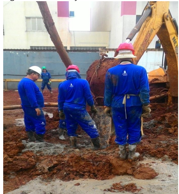
Figura 34 - Introdução total da armadura.
