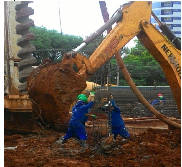
Figura 32 - Posicionamento da armadura.
