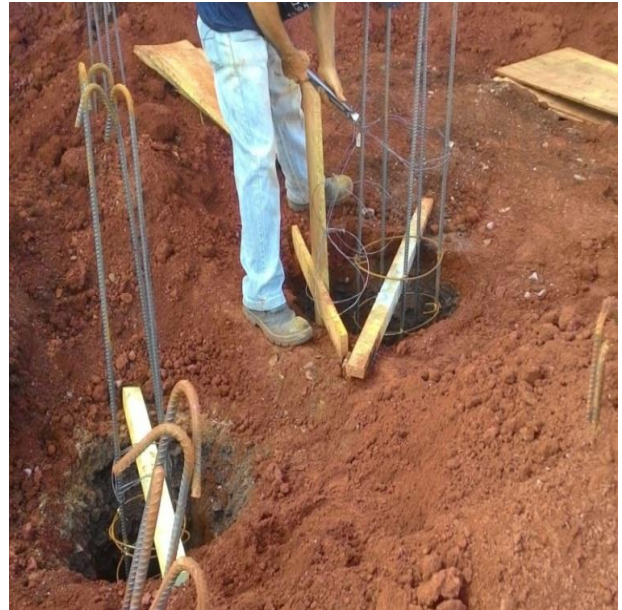
Figura 20 - Posicionamento da armadura.
