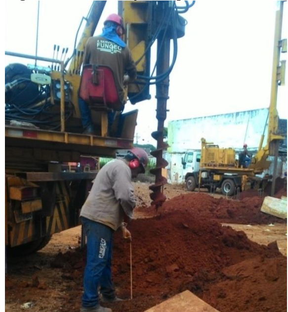
Figura 18 - Verificação da profundidade.
