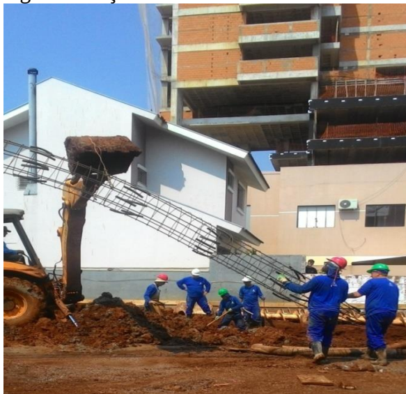
Figura 31- Içamento da armadura.
