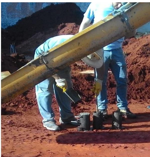
Figura 21 - Moldagem dos corpos-de-prova.
