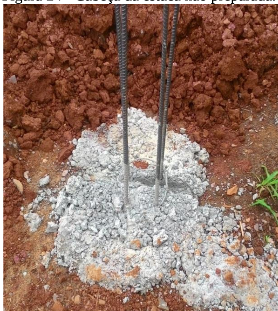
Figura 24 - Cabeça da estaca não preparada.
