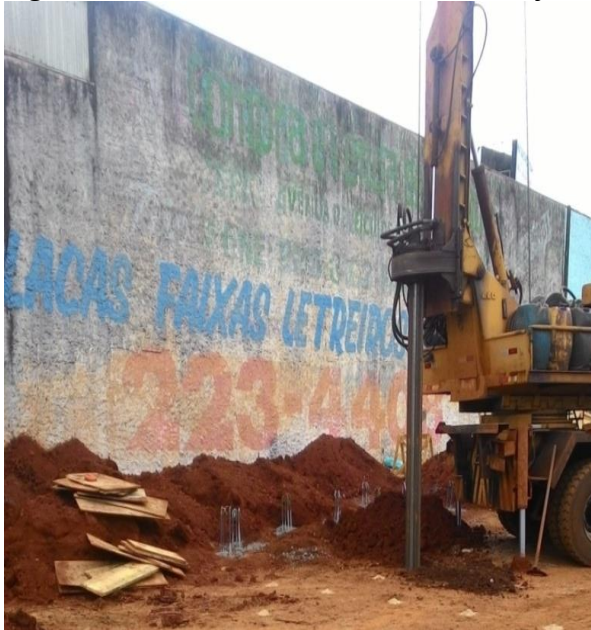
Figura 17 - Elemento realizando a escavação.
