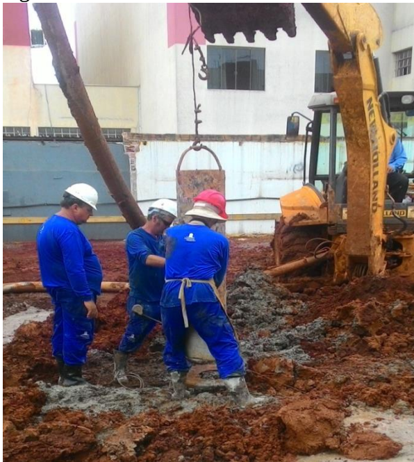
Figura 33 - Posicionamento do cilindro.
