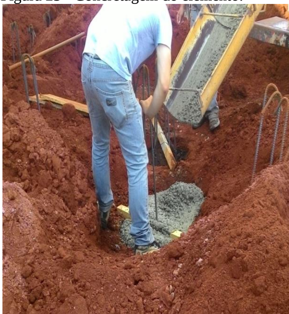
Figura 23 - Concretagem do elemento.
