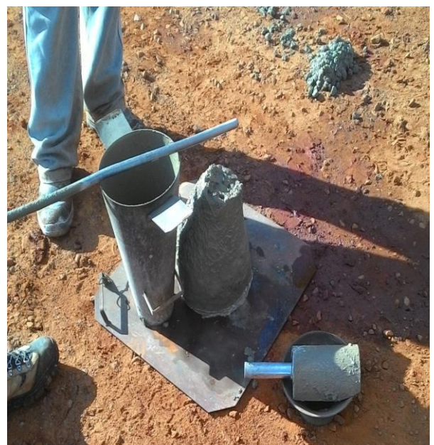
Figura 22 - Realização do Slump Test .
