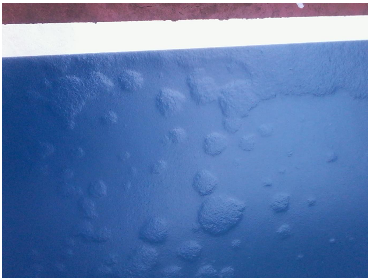
Figura 13: Bolhas na Pintura.
