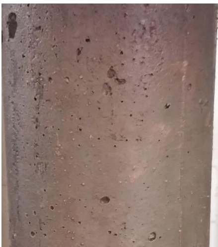
Figura 12 - Aspecto visual do concreto com fibras de aço
