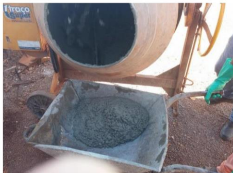
Retirada do concreto após adição de fibras e mistura em betoneira.
