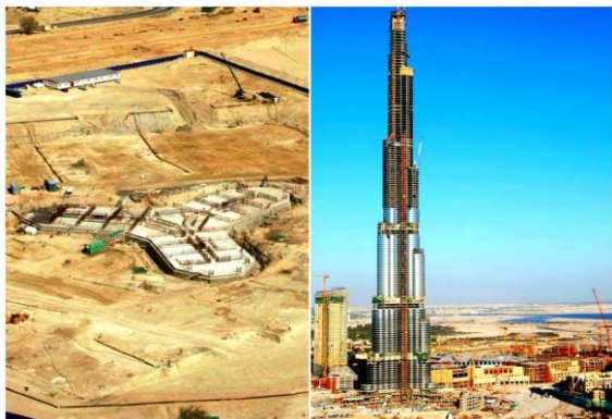
Figura 3 - Arranha-céu Burj Khalifa em construção Emirados Árabes Unidos
