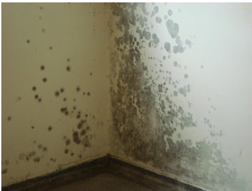
Figura 05 – Configuração de bolor em revestimento
