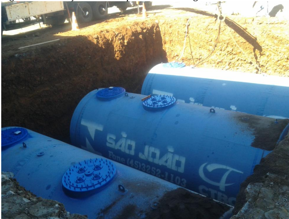
Figura 8 – Instalação novos tanques de armazenagem de combustíveis.
