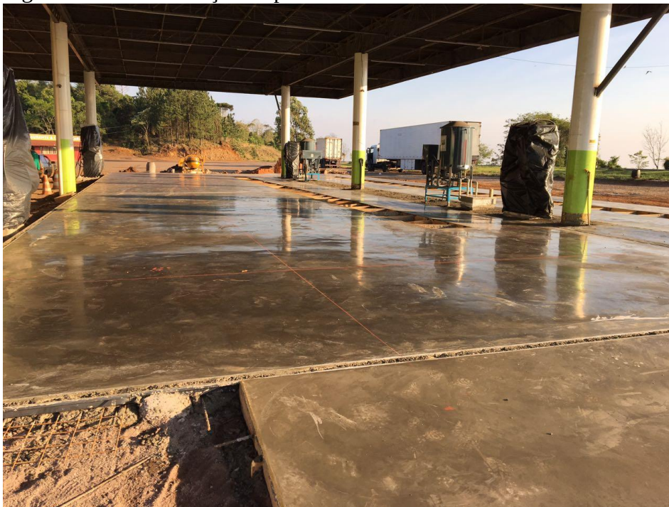
Figura 11 – Pavimentação da pista.
