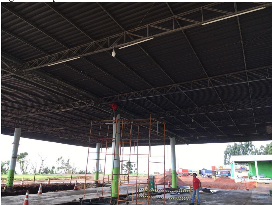
Figura 9 – Reparos na estrutura metálica da cobertura.
