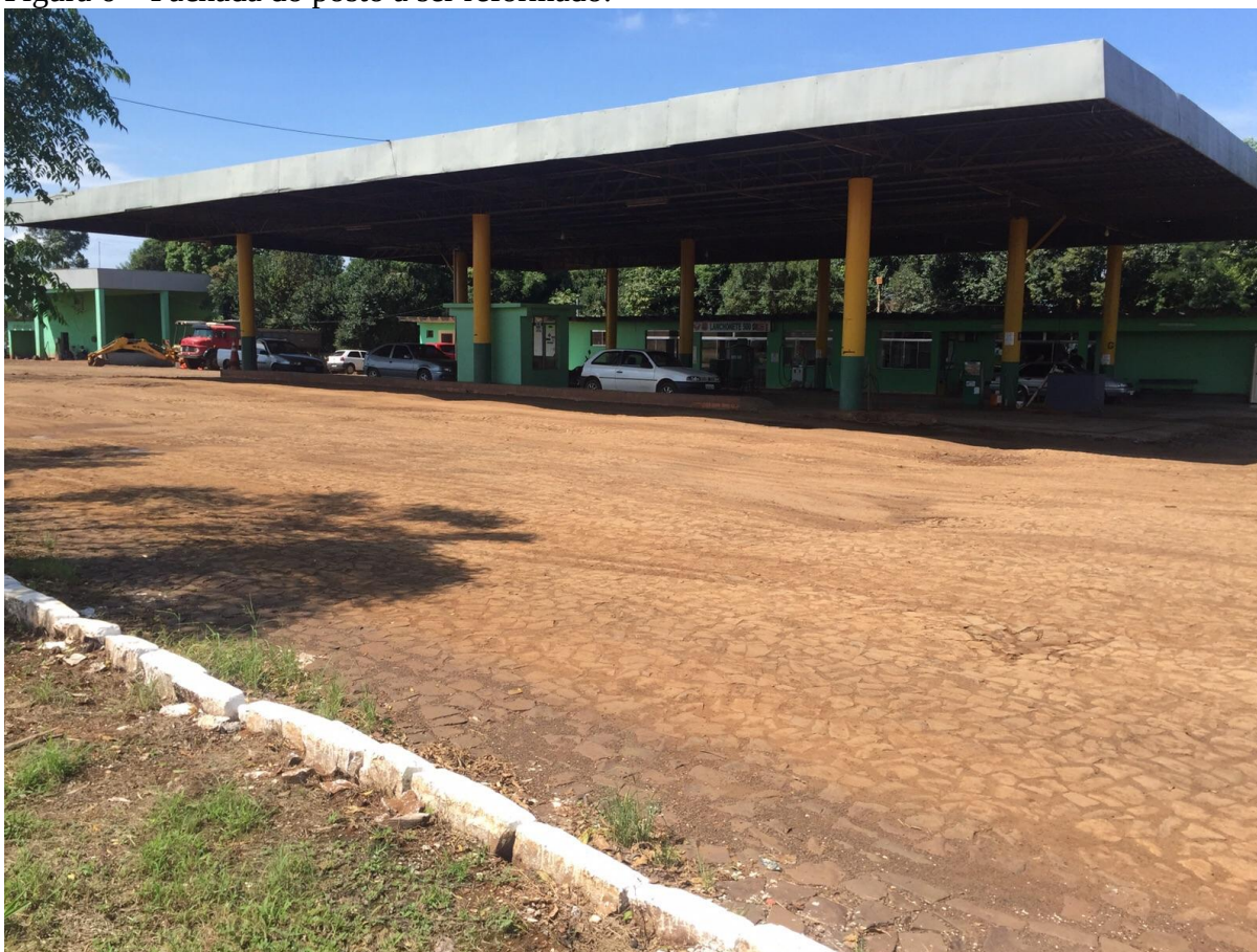
Figura 6 – Fachada do posto a ser reformado.
