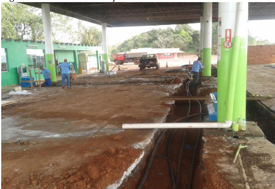
Figura 10 – Obras de instalações elétricas e hidráulicas.
