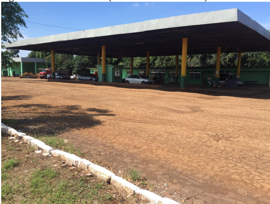
Figura 14 – Auto Posto 500 (antes do início das obras).
