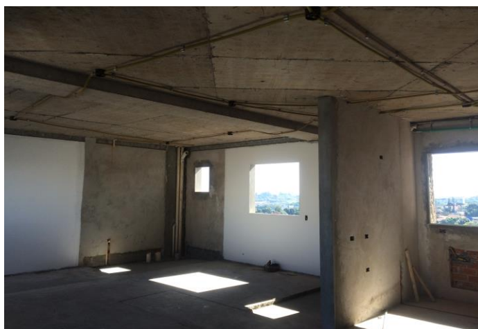
Figura 8 – Interior de uma Edificação que se utiliza da protensão e do Concreto Armado Fonte: Autor, 2016.
