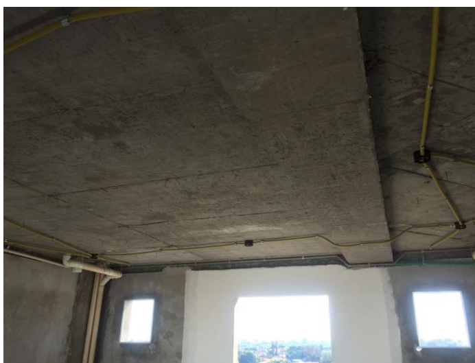
Figura 9 – Interior de uma edificação que se utiliza da Protensão e do Concreto Armado Fonte: Autor, 2016.
