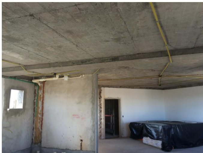
Figura 7 – Interior de uma Edificação que se utiliza da protensão e do Concreto Armado Fonte: Autor, 2016.
