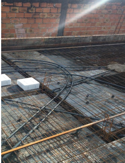
Figura 5: Eletrodutos locados em laje.
