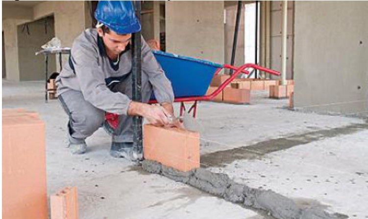
Figura 11: Assentamento da primeira fiada.
