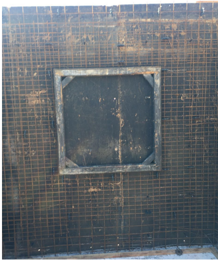
Figura 20: Montagem da armadura
