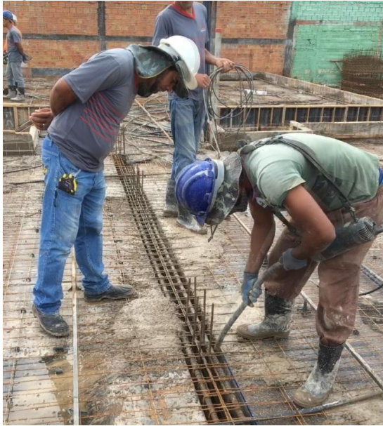
Figura 9: Adensamento.
