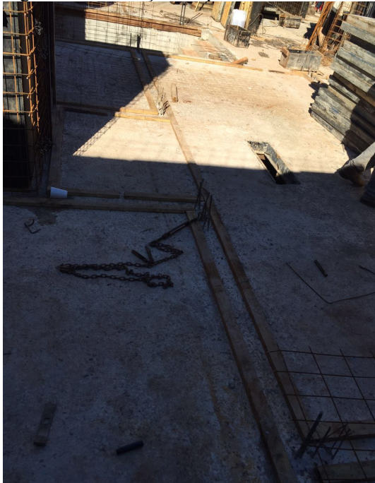
Figura 18: Marcação do piso.
