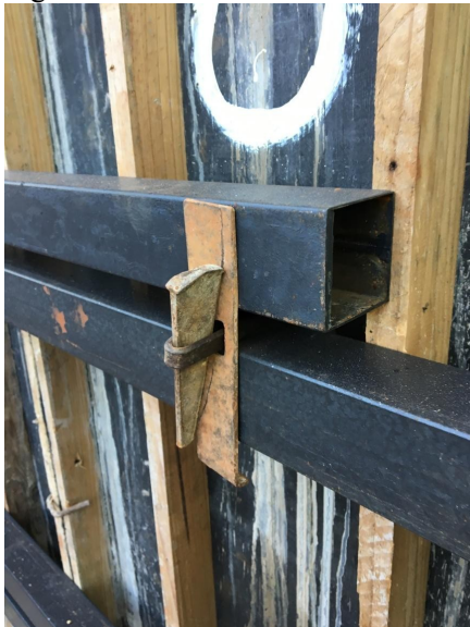
Figura 4: Cunha de travamento de fôrma.
