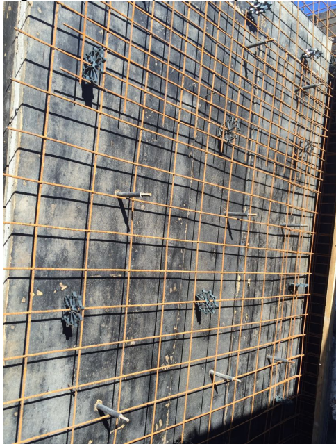
Figura 21: Colocação dos espaçadores
