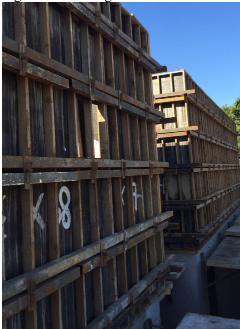
Figura 19: Montagem de fôrmas
