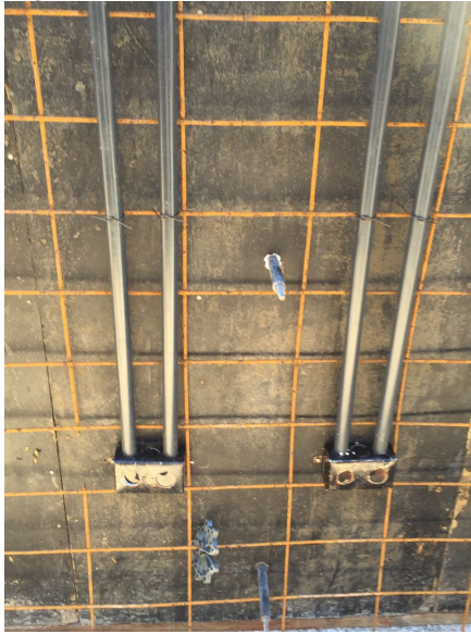
Figura 22: Execução das instalações
