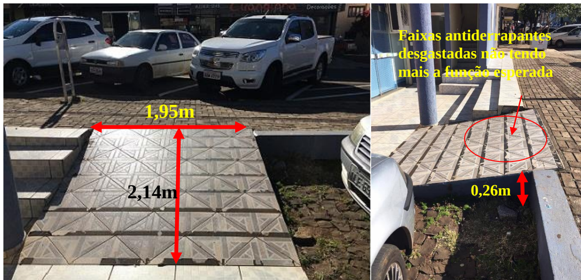
Figura 83 - Rampa de acesso ao estabelecimento
