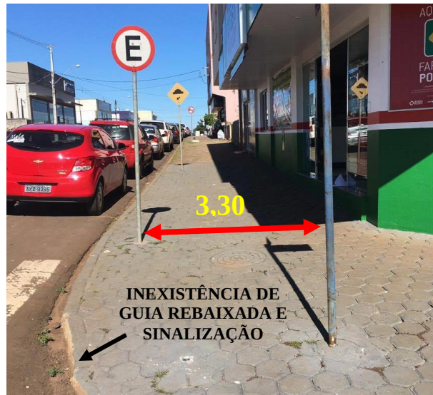
Figura 33 - Calçada de acesso ao estabelecimento
