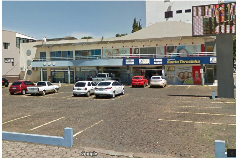
Figura 27 - Fachada Farmácia Matriz
