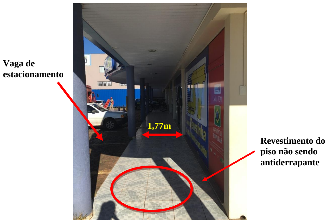
Figura 79 - Calçada transpassando a fachada
