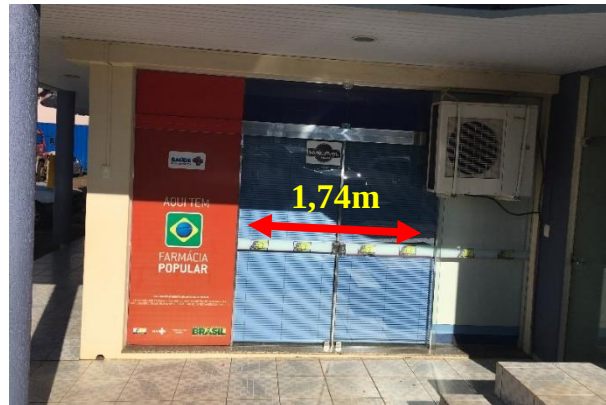
Figura 82 - Porta de acesso lateral
