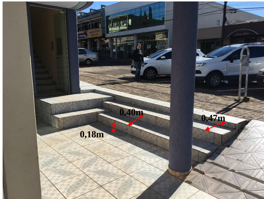
Figura 86 - Escada de acesso
