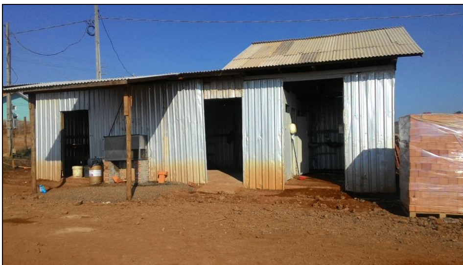
Figura 08 – Refeitório, vestiário e banheiros.
