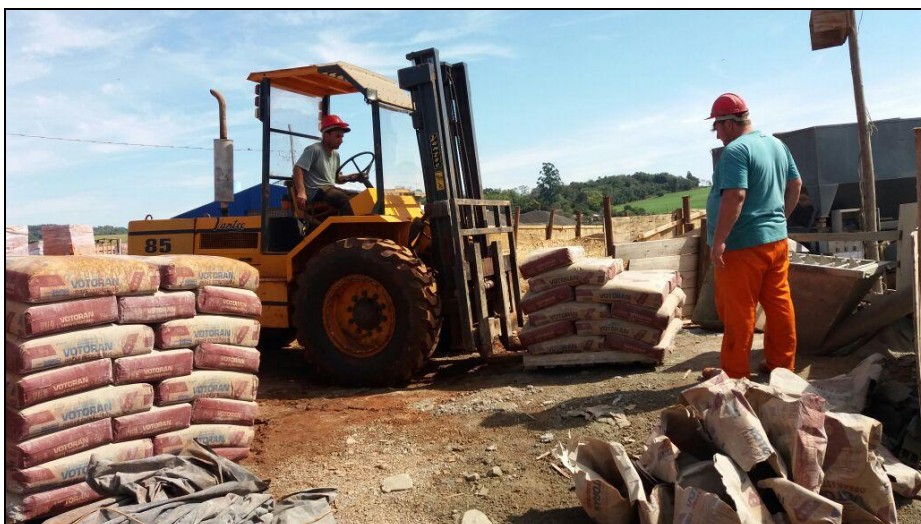
Figura 22 – Transporte dos sacos de cimento.
