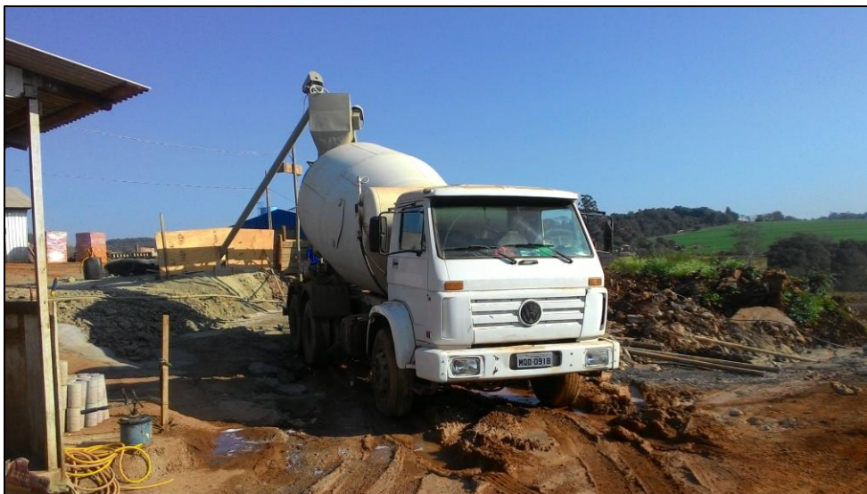
Figura 17 – Usina de concreto.
