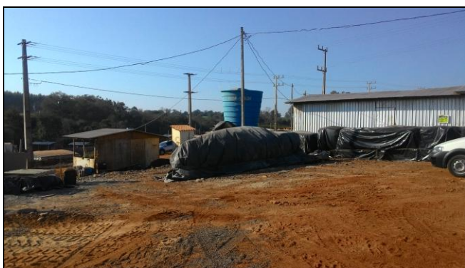
Figura 13 – Estoque de cimento.
