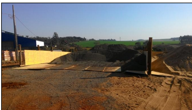
Figura 12 – Estoque de areia e pedra brita.
