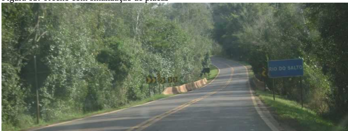
Figura 03: Trecho com sinalização de placas
