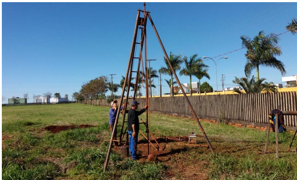
Figura 33 - Realização do ensaio SPT
