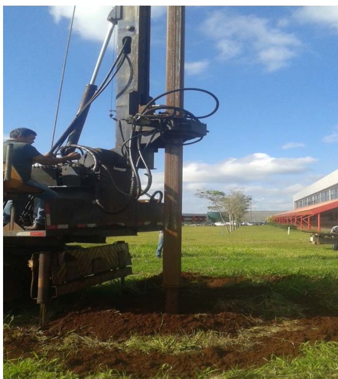
Figura 26 - Abertura do poço de inspeção
