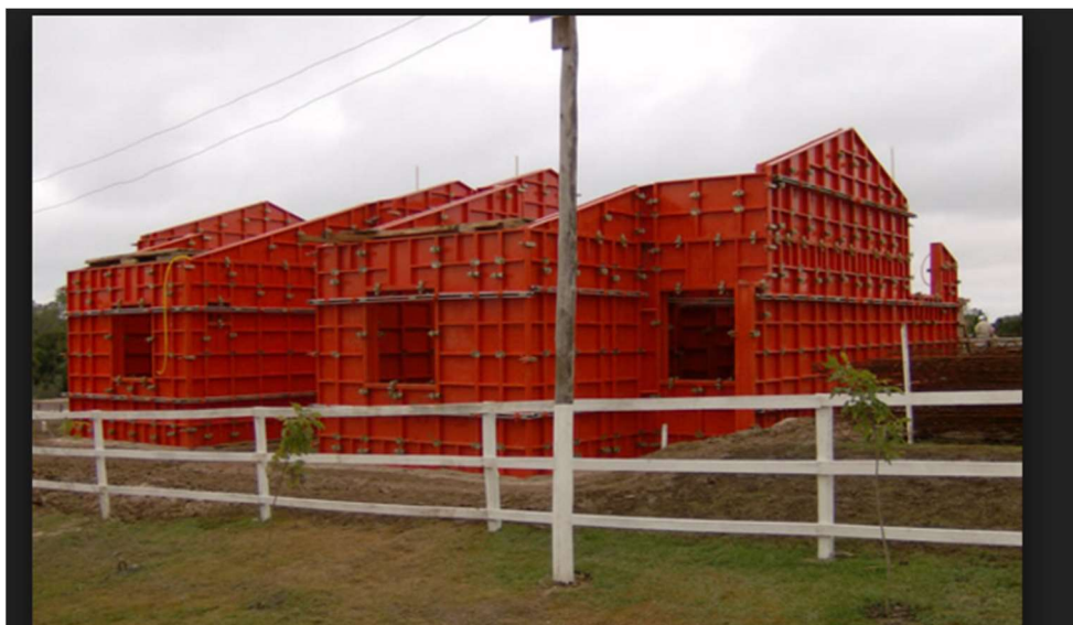
Figura 09 – Fôrmas de paredes de concreto.
