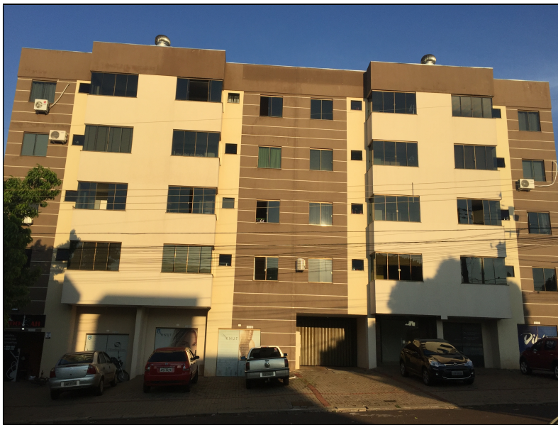
Figura 02 – Fachada da edificação.
