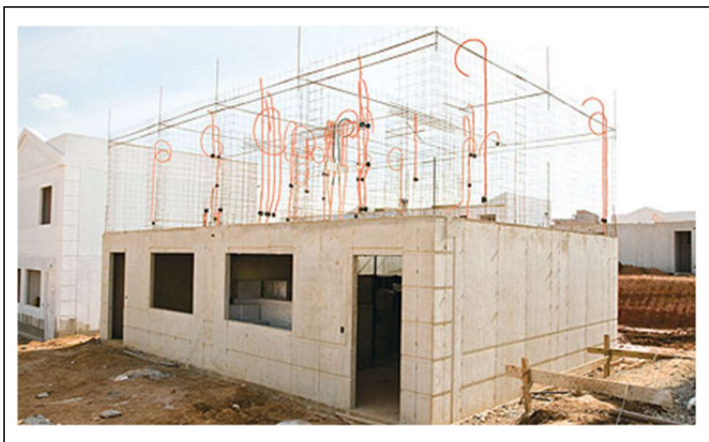
Figura 08 – Paredes de concreto.
