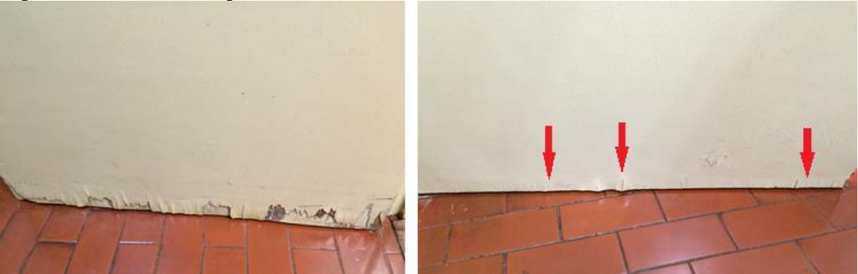
Figura 17 – Umidade na porta do banheiro
