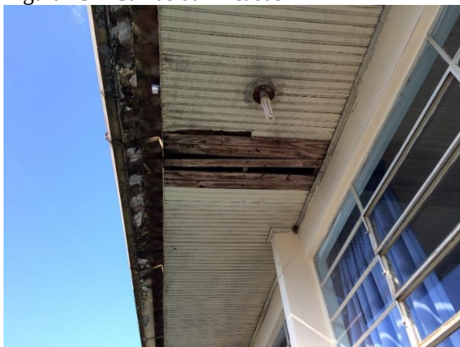
Figura 15 – Calhas danificadas
