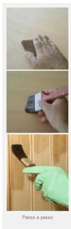
Figura 16 – Reparo da patologia infiltração
