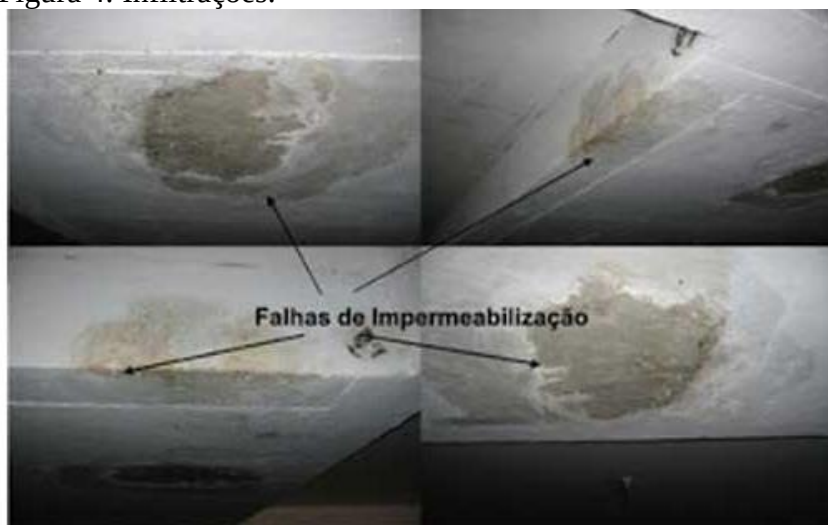
Figura 4: Infiltrações.
