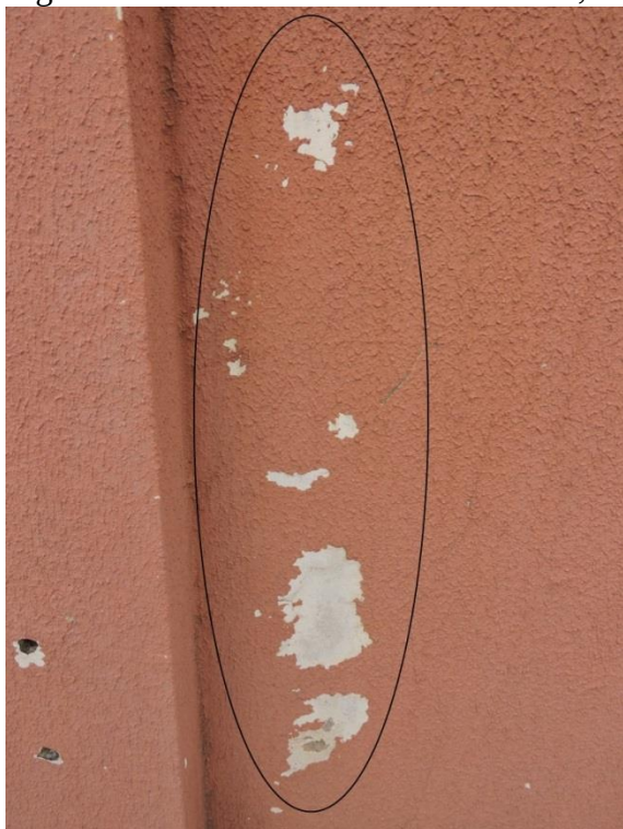
Figura 20: Destacamento na área externa, na face Oeste do bloco 04.
