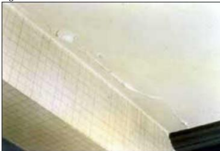
Figura 7: Destacamento.
