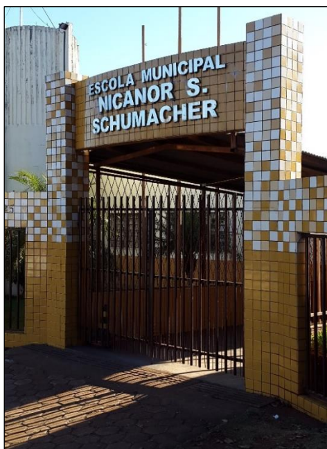
Figura 48 – Portão de acesso principal
