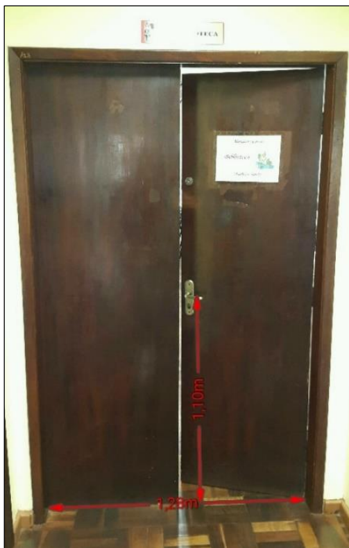
Figura 75 – Porta de acesso para a biblioteca
