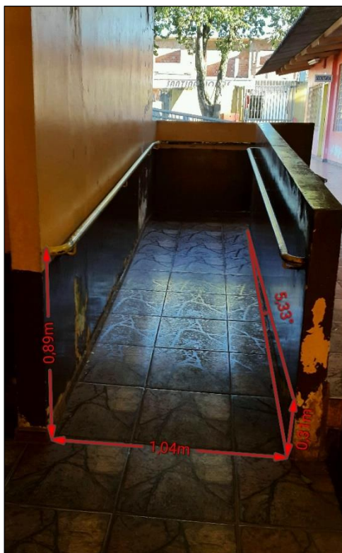
Figura 27 – Área baixa da rampa de acesso às salas de aula e banheiros
