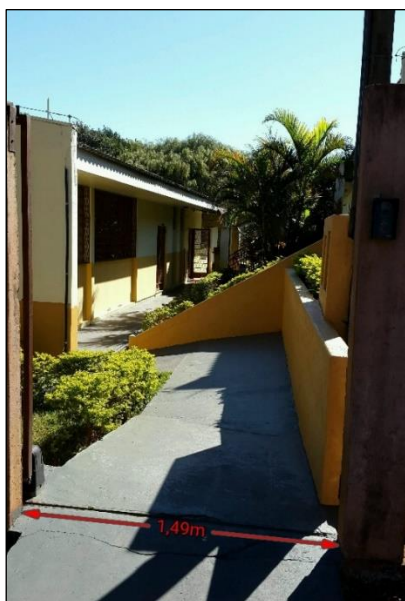
Figura 49 – Portão de acesso secundário
