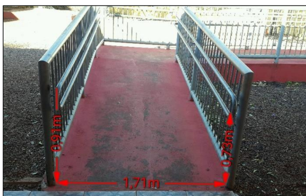
Figura 20 – Altura do corrimão de altura dupla da rampa de acesso principal
