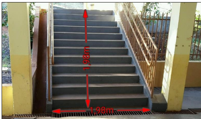
Figura 55 – Escada de acesso bloco 2 para o bloco 1
