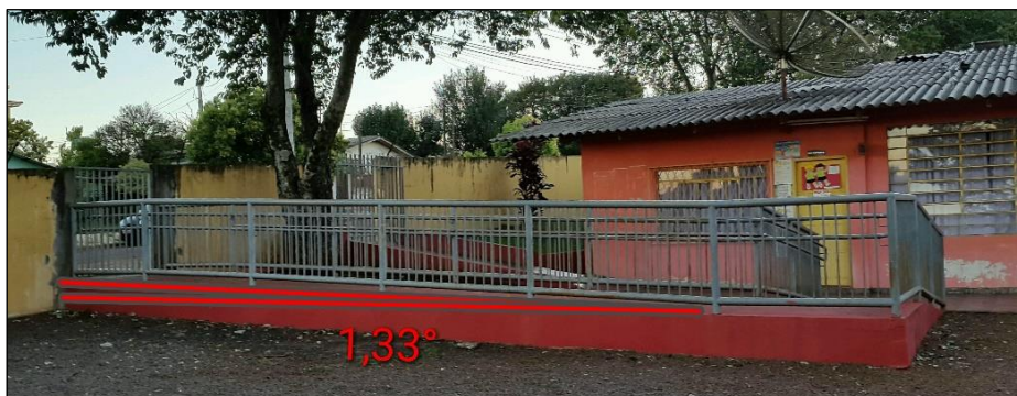
Figura 19 – Rampa de acesso principal
