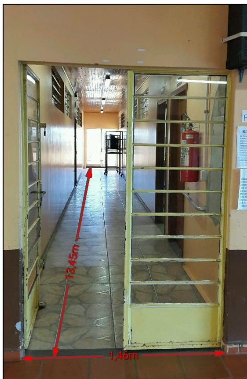
Figura 25 – Corredor do bloco 1, salas em nível
