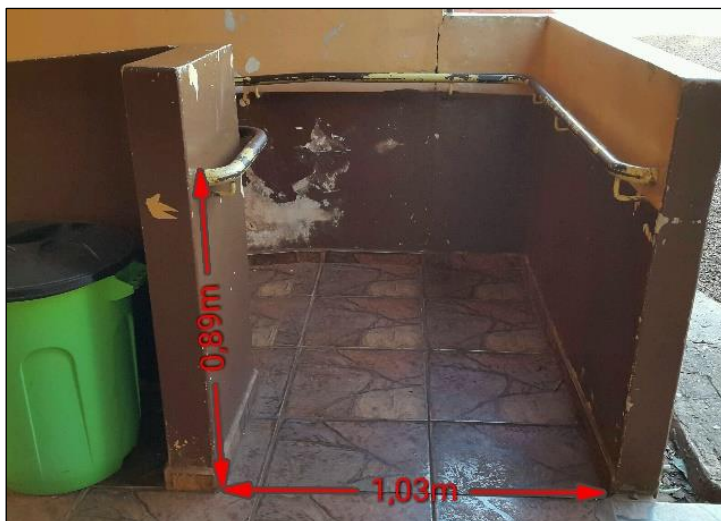
Figura 26 – Área alta da rampa de acesso às salas de aula do bloco 2 e banheiros
