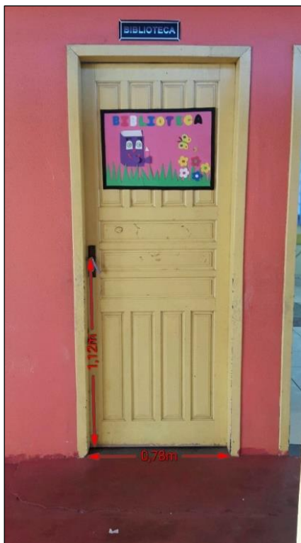
Figura 46 – Porta de acesso para a biblioteca
