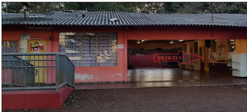
Figura 24 – Bloco 1 em nível após a saída da rampa principal
