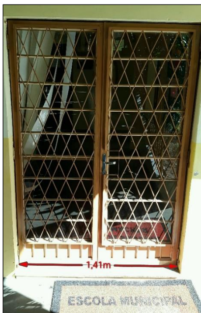
Figura 74 – Porta de acesso para o bloco 3
