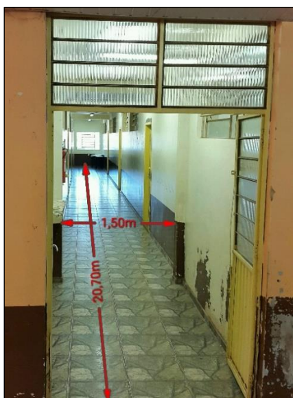
Figura 31 – Corredor do bloco 2, salas em nível
