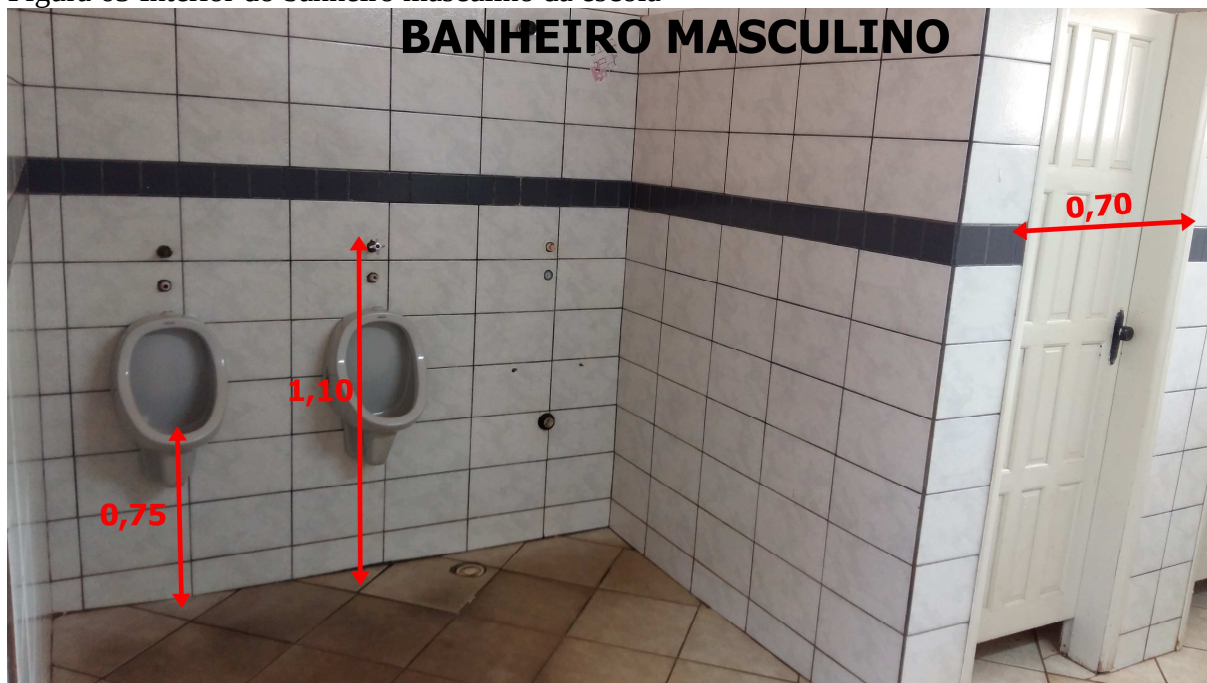
Figura 65 Interior do banheiro masculino da escola
