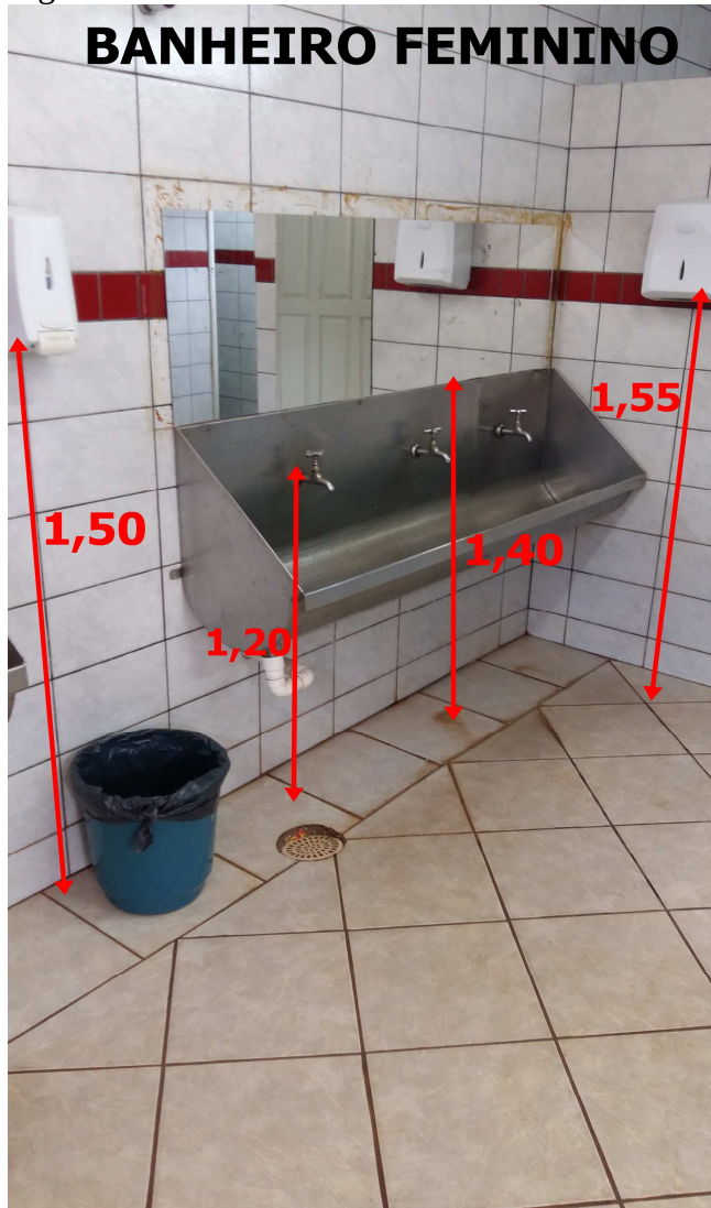
Figura 67 Interior do banheiro feminino da escola
