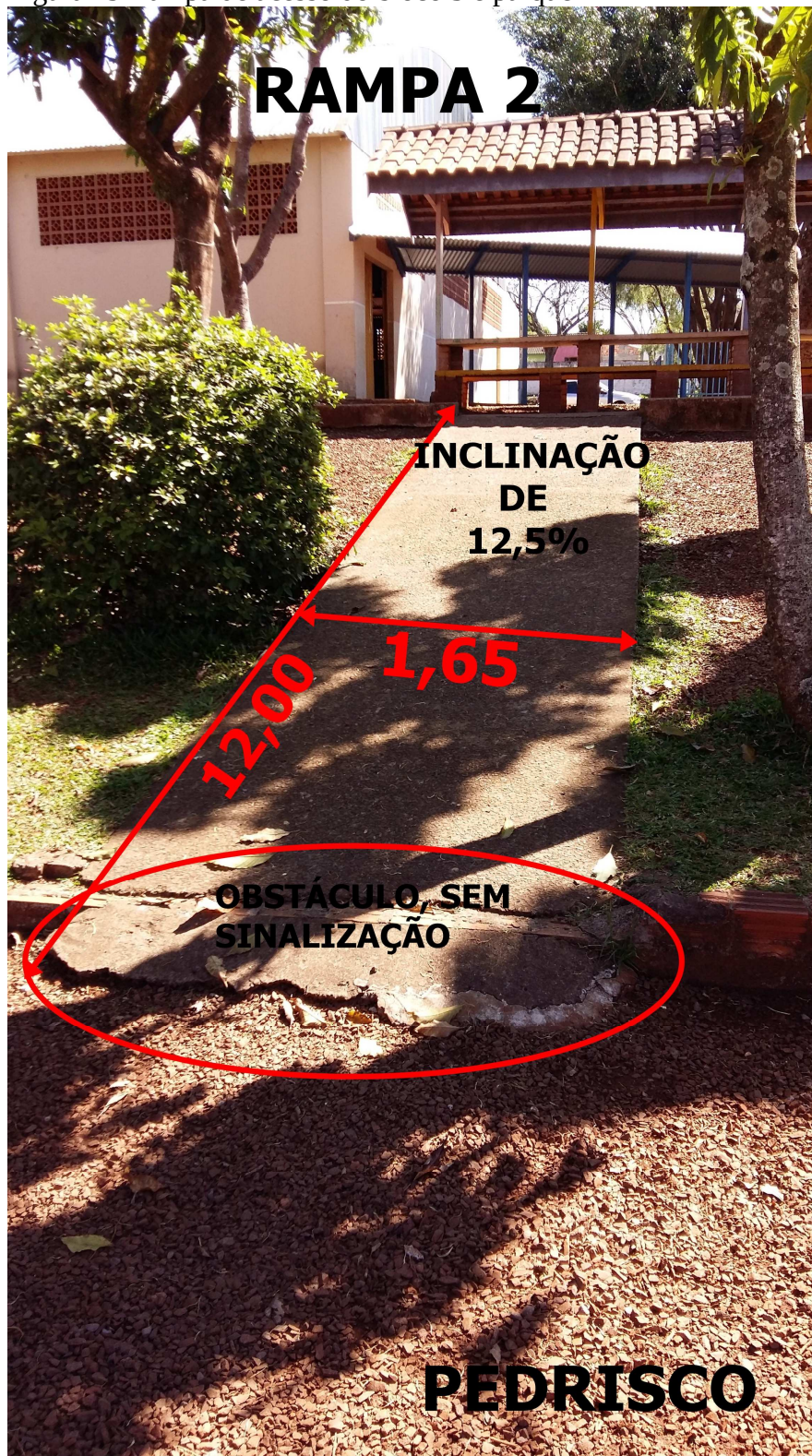
Figura 49 Rampa de acesso do bloco 3 e parque
