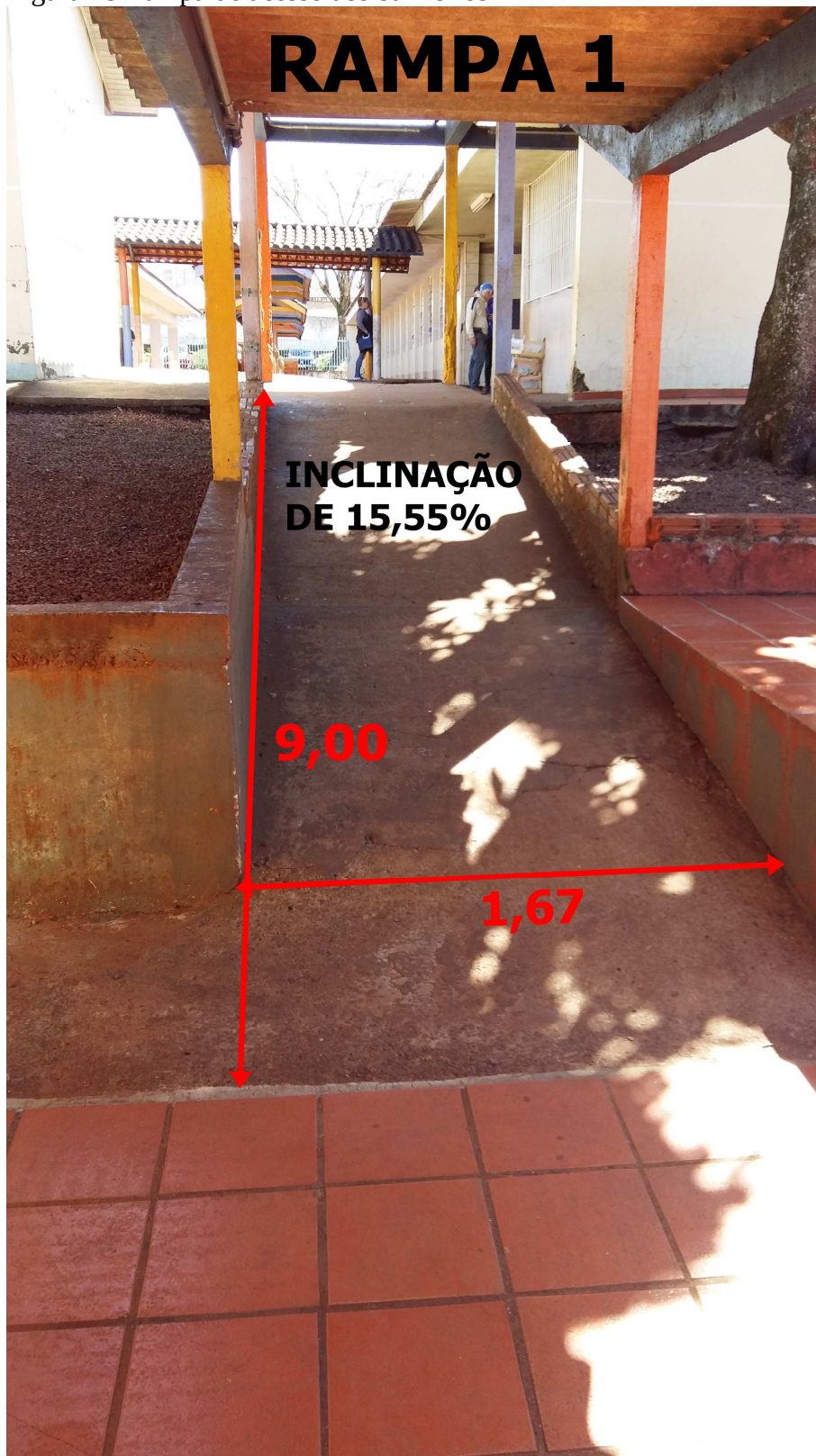
Figura 48 Rampa de acesso aos banheiros
