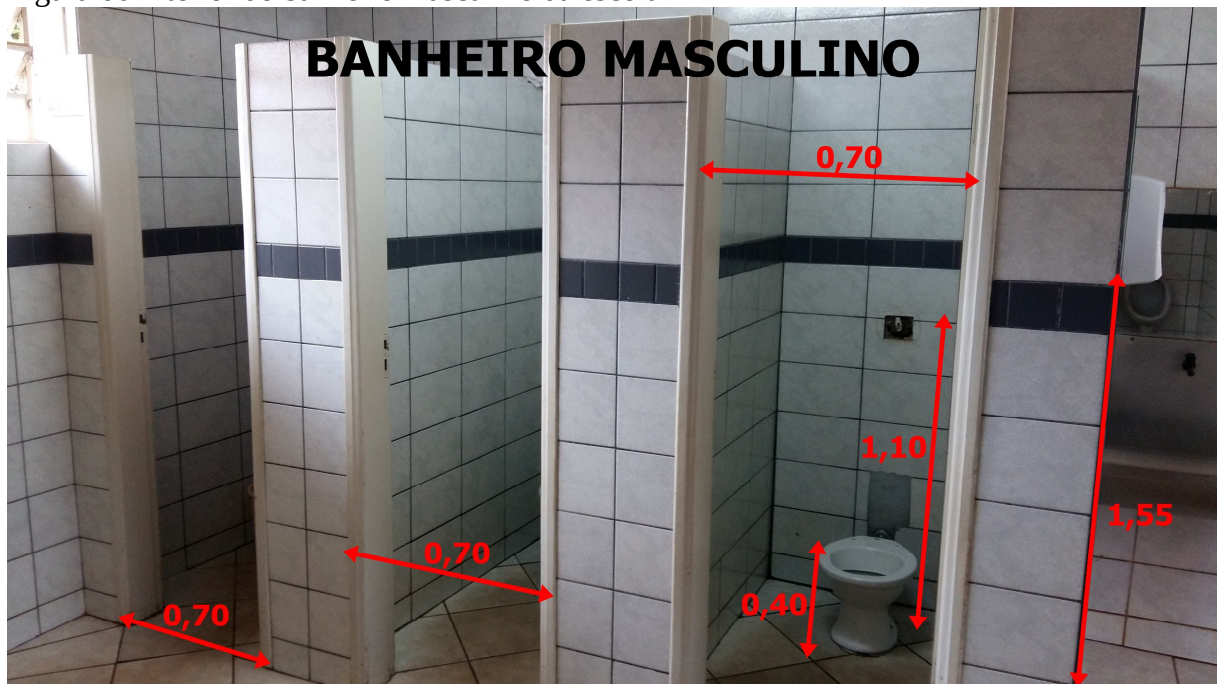
Figura 66 Interior do banheiro masculino da escola
