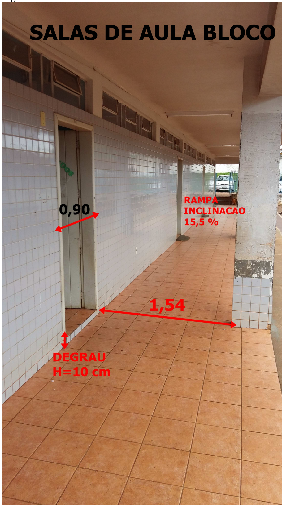
Figura 46 Vista externa das salas de aulas
