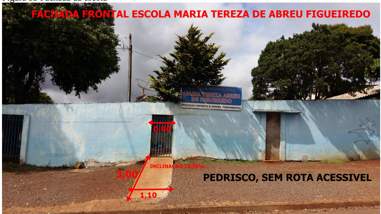
Figura 33 Fachada da escola
