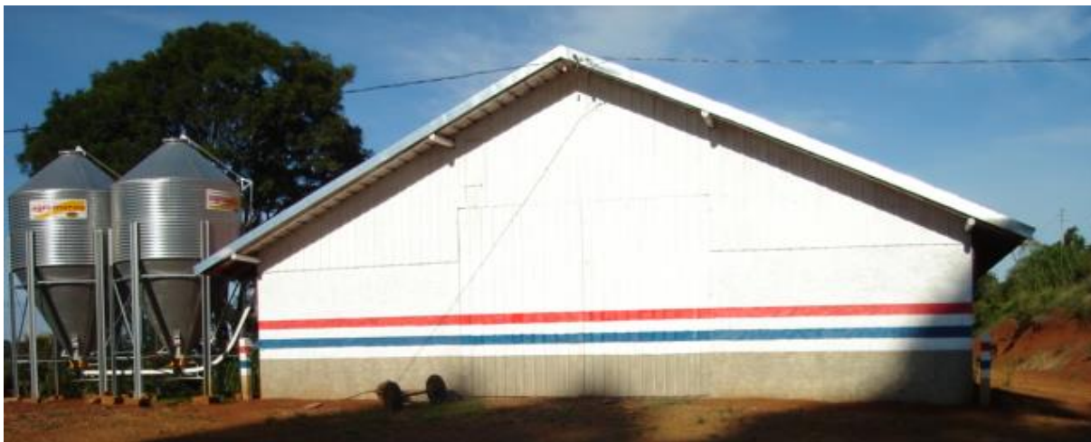
Figura 1.2 - Imagem da face frontal do galpão
