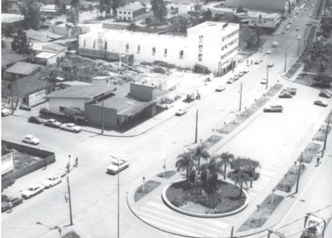
Imagem 01. A Praça do Migrante, Foto de 06/11/1977, durante sua construção.
