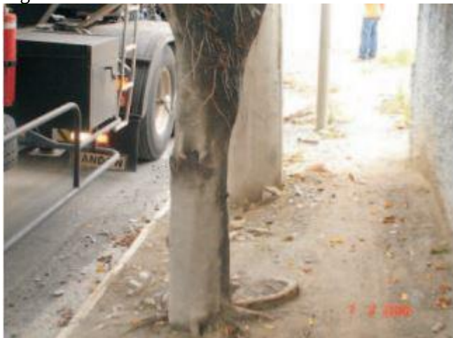
Figura 8: Excesso de obstáculos afetando a acessibilidade.
