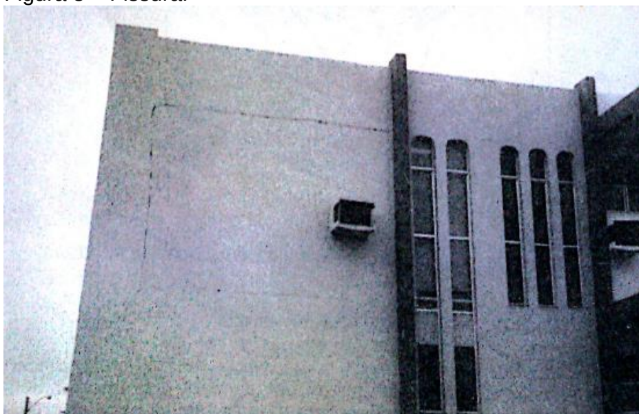
Figura 3 – Fissura.
