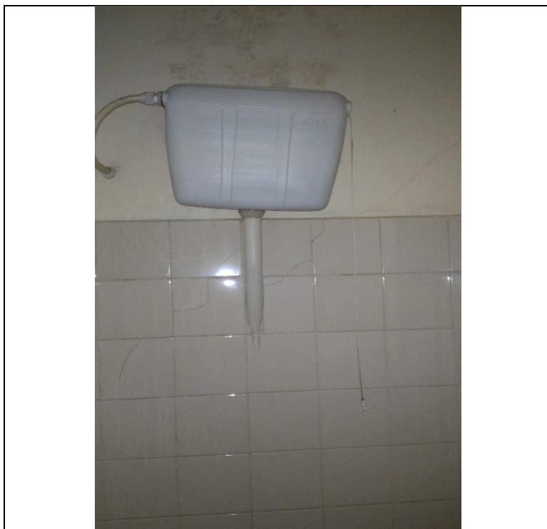
Figura 12 - Amostra 41, trinca inclinada a 45° devido à recalque diferencial.
