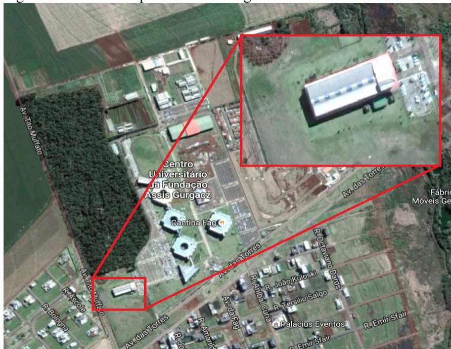
Figura 10 – Centro Experimental de Engenharia do Centro Universitário FAG
