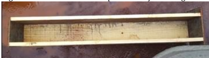
Figura 12 – Fôrma em madeira para realização de verga e contraverga.
