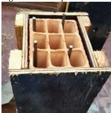
Figura 15 – Inserção de armadura método Construtora X.
