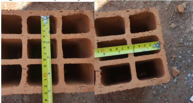
Figura 25 – Seção disponível para preenchimento de concreto.
