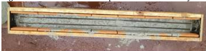
Figura 14 – Fôrma em madeira para alinhamento dos tijolos canaleta.
