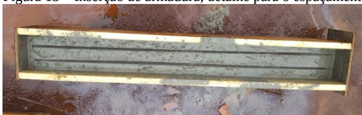
Figura 13 – Inserção de armadura, detalhe para o espaçamento da armadura.
