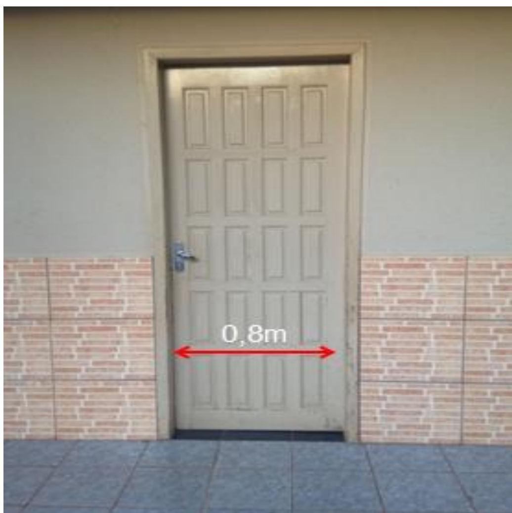
Figura 17: Porta de acesso a sala de aula.
