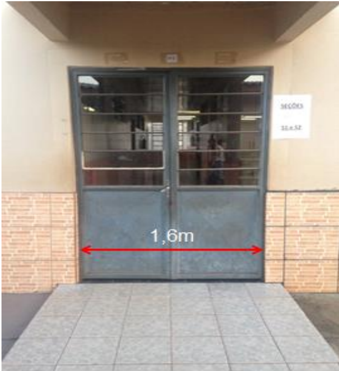
Figura 16: Porta de acesso a circulação entre as salas de aula.
