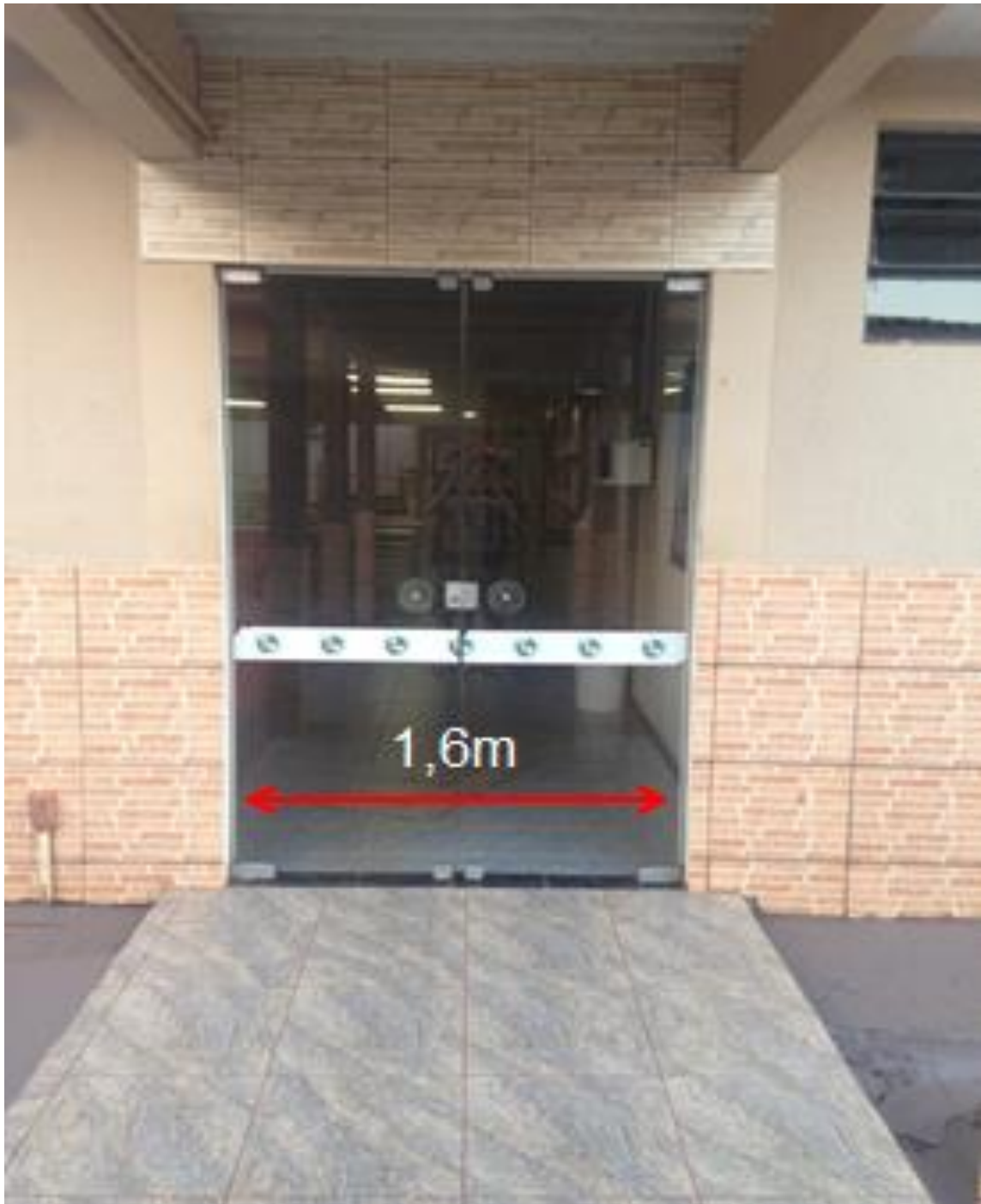
Figura 15: Porta de acesso a supervisão pela parte interna.
