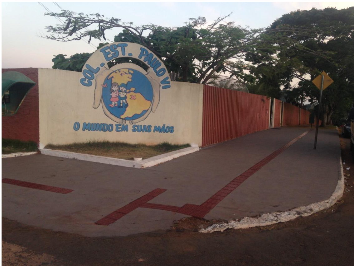
Figura 6: Calçamento de acesso ao colégio, em concreto maciço, e com piso tátil com alerta de mudança de direção.
