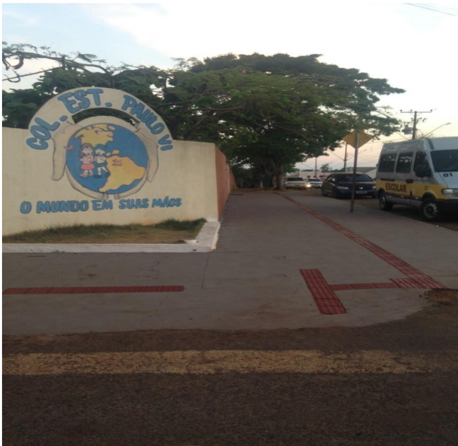
Figura 7: Guia rebaixada 1, com medidas adequadas e falta de sinalização internacional de acesso.
