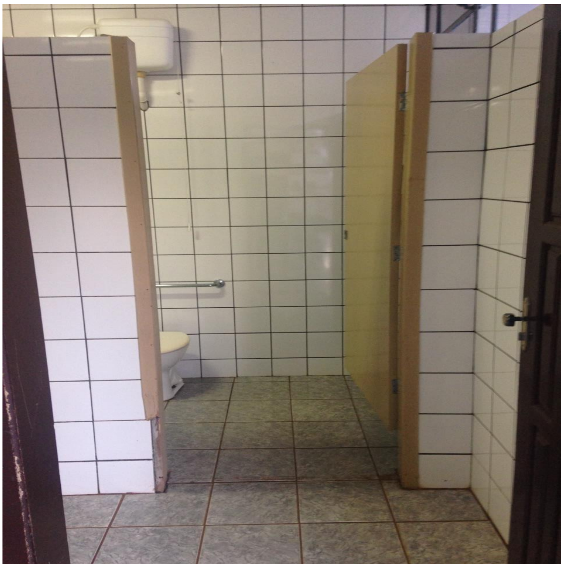
Figura 20: Porta de acesso ao sanitário.
