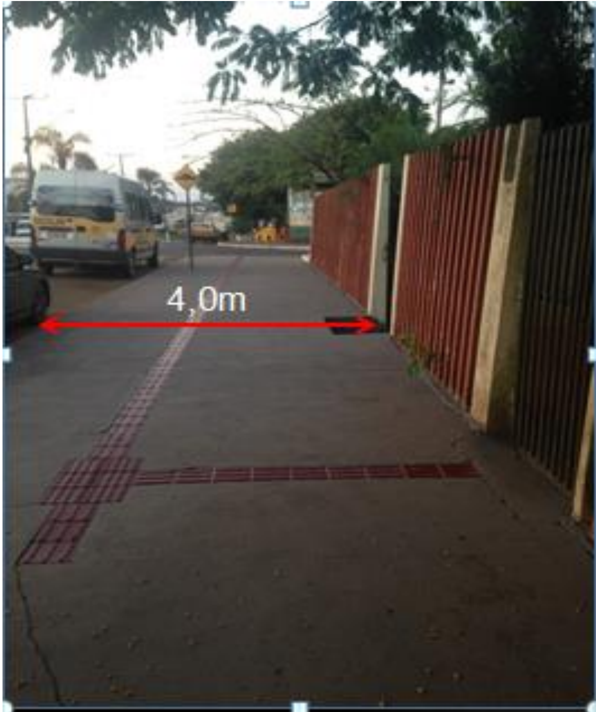
Figura 5: Calçamento de acesso ao colégio, em concreto maciço, e com piso tátil com alerta de mudança de direção.
