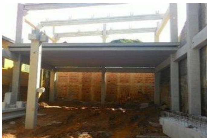
Figura 5 - Estrutura executada com junta a seco
