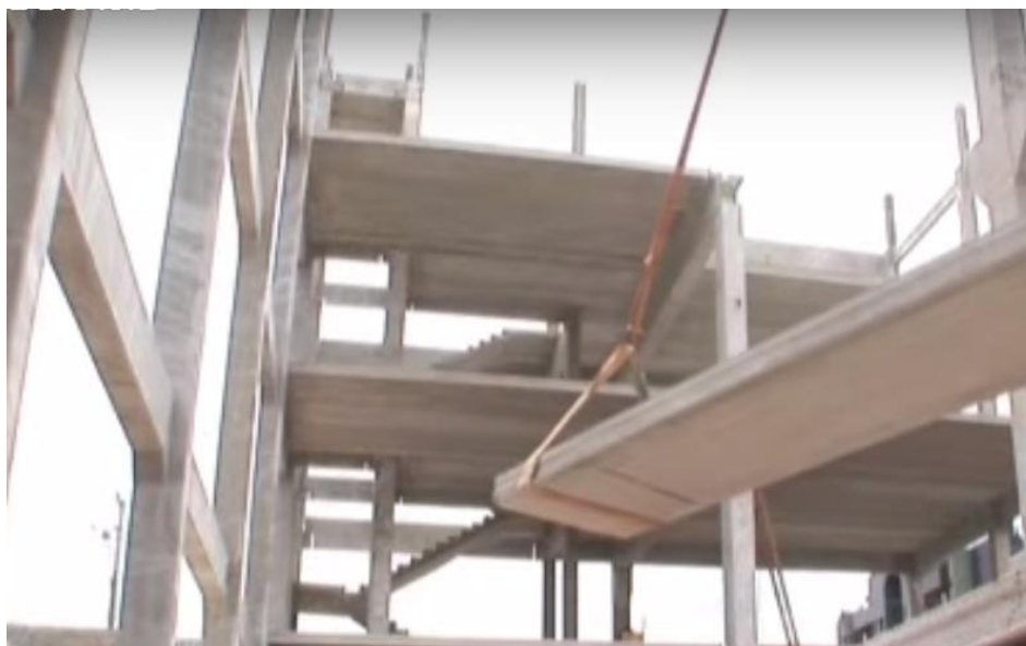
Figura 4 – Elemento pré-moldado laje sendo içada no esqueleto estrutural
