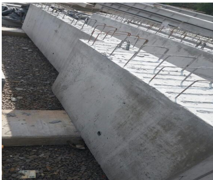
Figura 2 – Elementos pré-moldado apoiado sobre apoios de vigas
