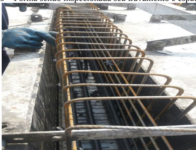
Figura 9 - Forma sendo inspecionada seu travamento e espaçamento
