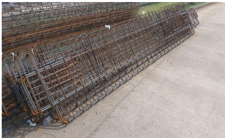
Figura 8 - Armaduras sem torções e deformações armazenadas
