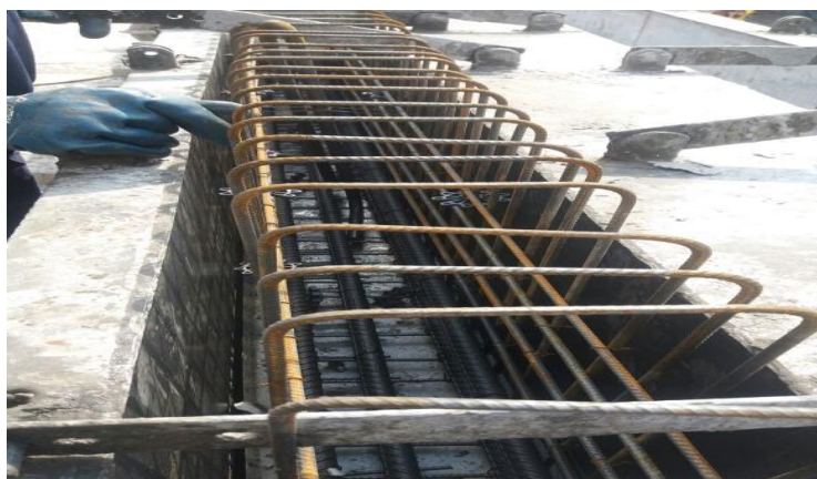
Figura 1 – Produção dos elementos no canteiro
