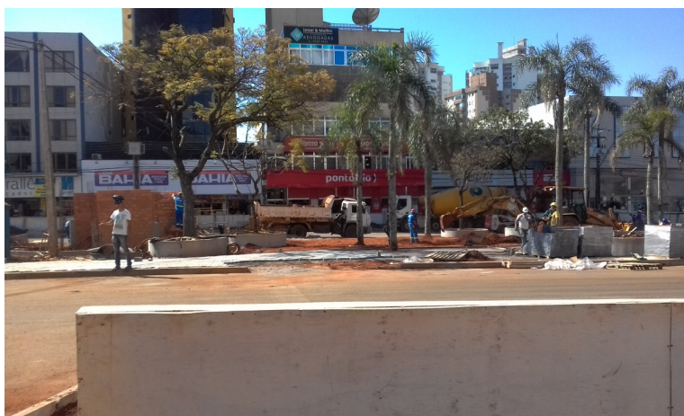
Figura 01 – Canteiro de Obra (Av. Brasil)
