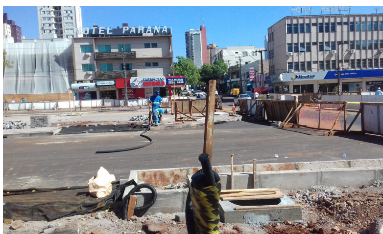
Figura 02 – Canteiro de Obra (Av. Brasil)
