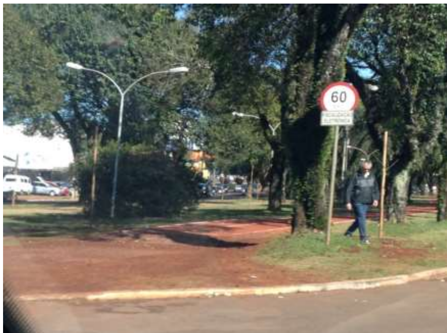
Figura 01: Pista de Caminhada e Ciclovia não acabadas
