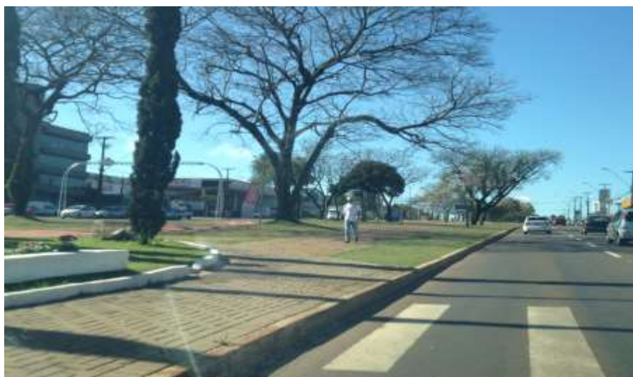
Figura 02: Faixa de Pedestre sem a rampa de acessibilidade para pessoas com necessidades especiais
