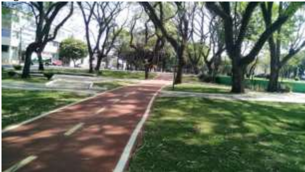
Figura 1 – Ciclovia finalizada e sinalizada.
