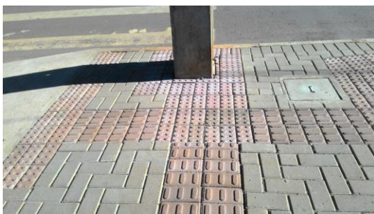
Figura 04 – Piso tátil com sinalização de alerta e com sinalização direcional.
