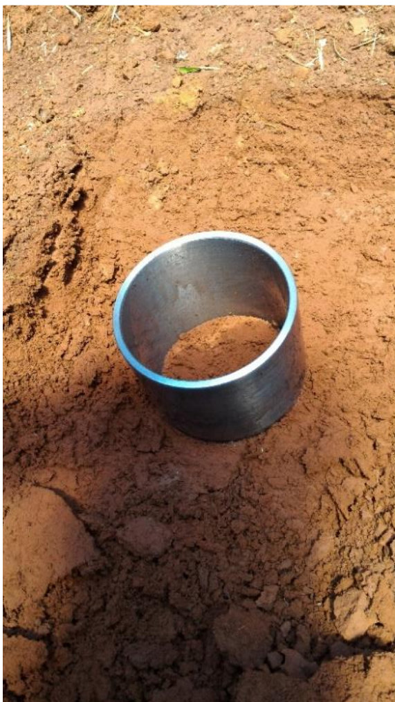
Figura 3.2 – Camisa metálica sendo cravada no solo
