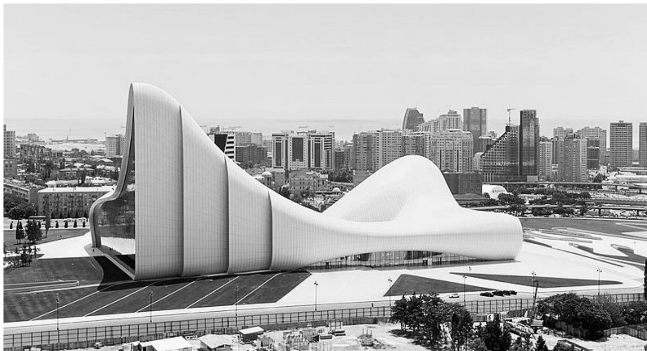
Figura 06. Perspectiva Vista do Ângulo Noroeste da Edificação.
