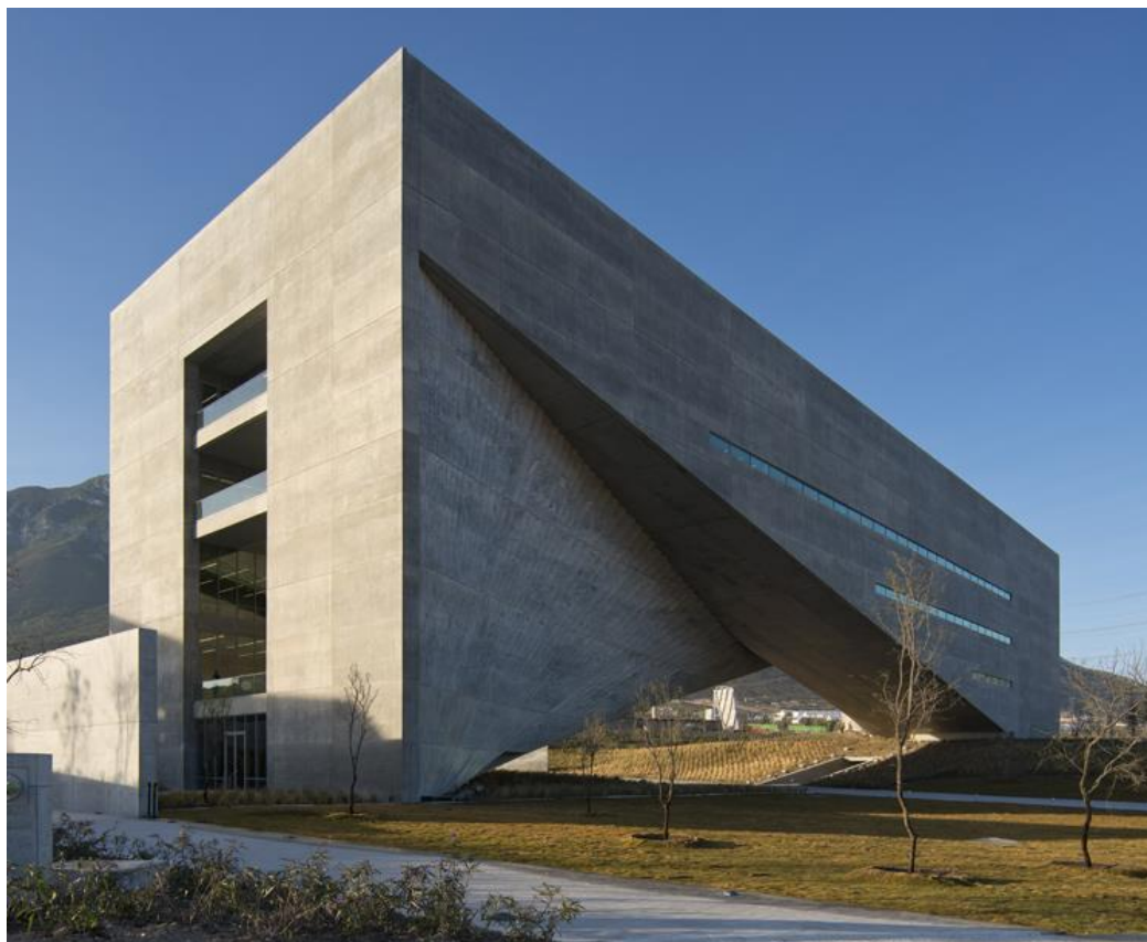
Figura 5- Obra Centro Roberto Garza Sada.
