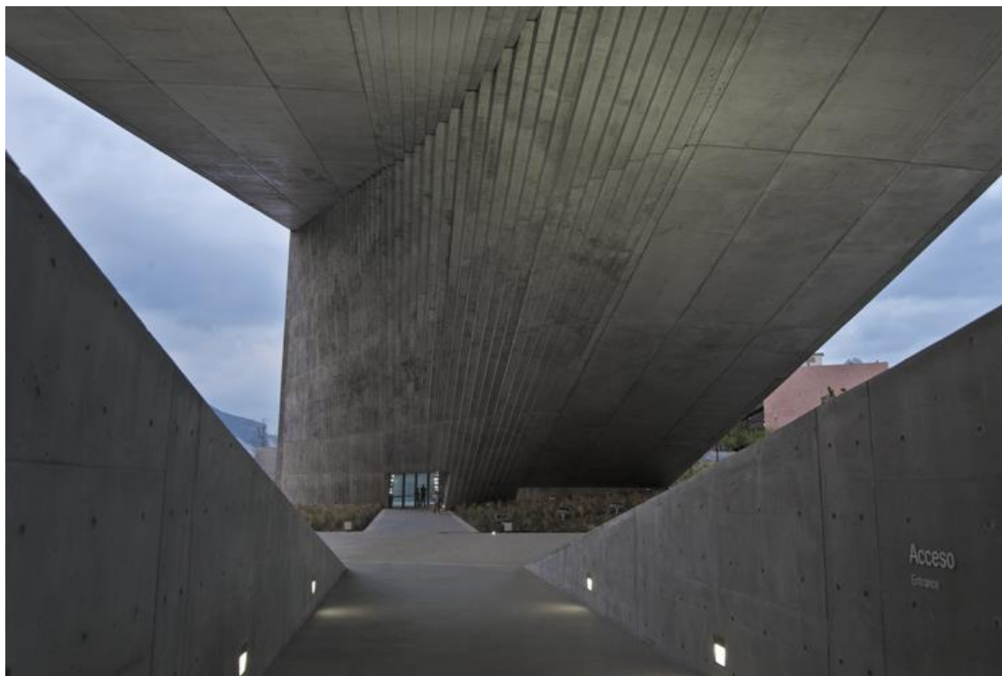
Figura 6- Obra Centro Roberto Garza Sada.
