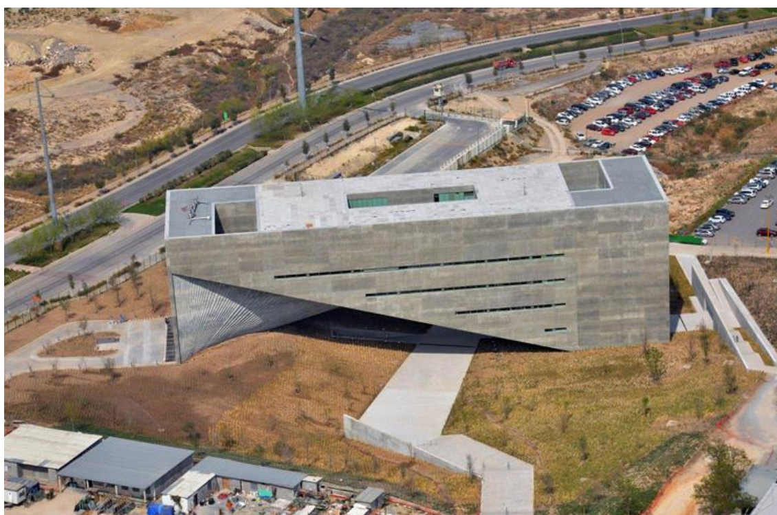
Figura 4- Obra Centro Roberto Garza Sada.
