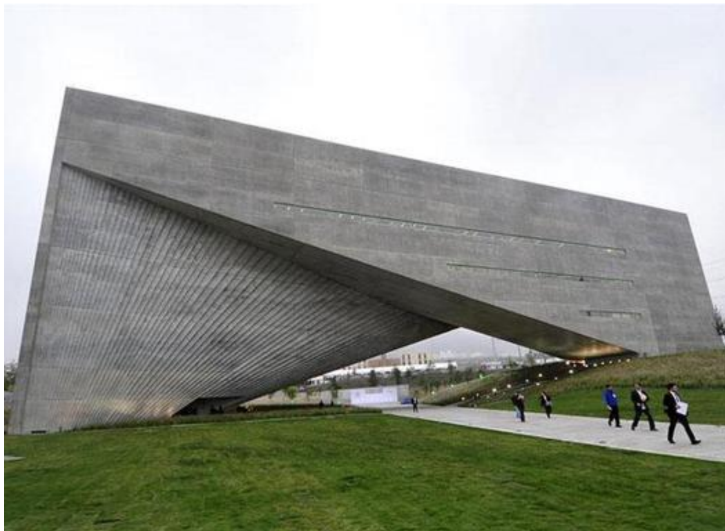
Figura 7- Obra Centro Roberto Garza Sada.
