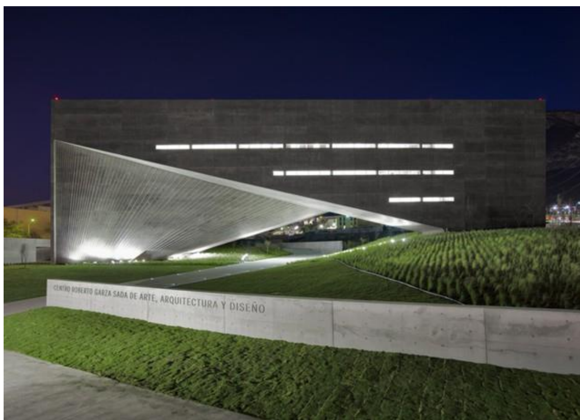
Figura 3- Obra Centro Roberto Garza Sada.
