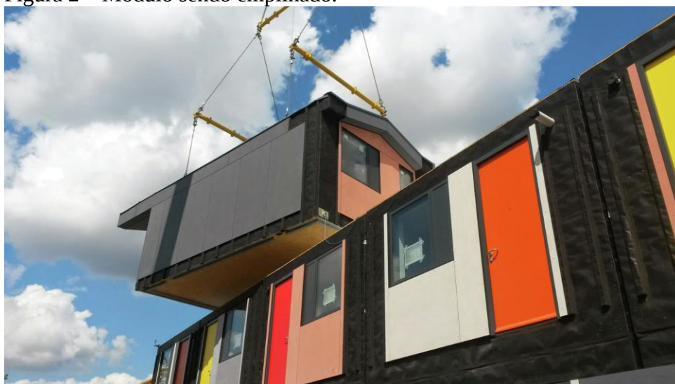
Figura 2 – Módulo sendo empilhado.
