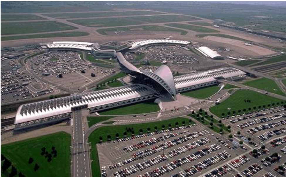
Figura 11 – Entorno em que a obra está inserida
