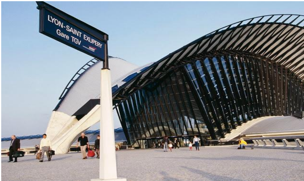
Figura 10 – imagem externa estação Gare de Lyon
