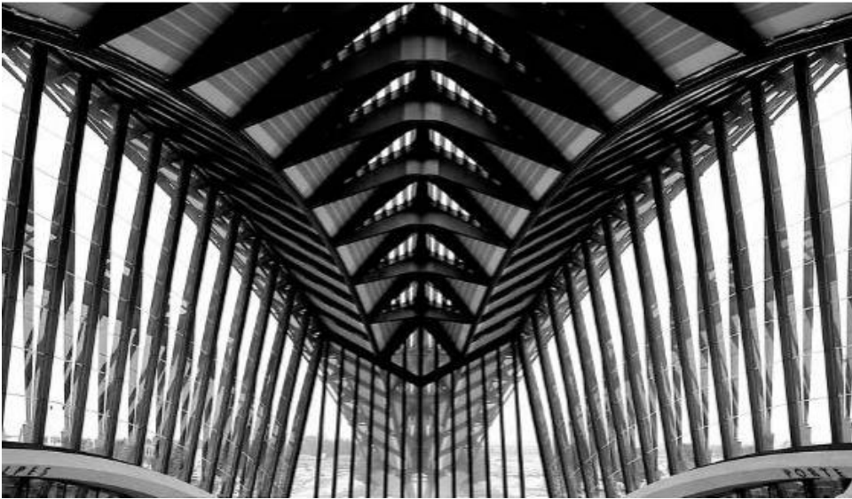
Figura 08 – Estrutura da Estação
