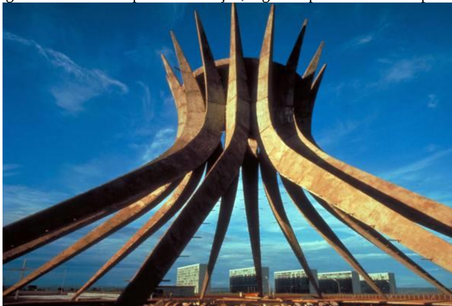
Imagem 3: Primeira etapa da construção, erguida apenas a estrutura principal
