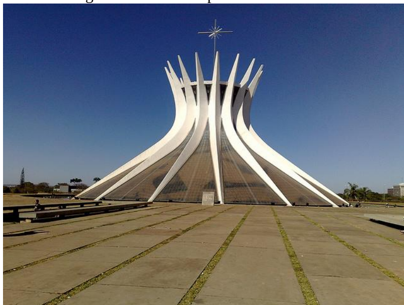
Imagem 4: Catedral depois da obra concluída
