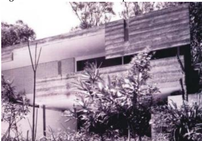
Figura 10. Vista da entrada na época.
