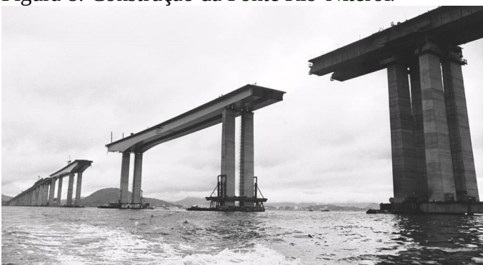
Figura 8. Construção da Ponte Rio-Niterói.
