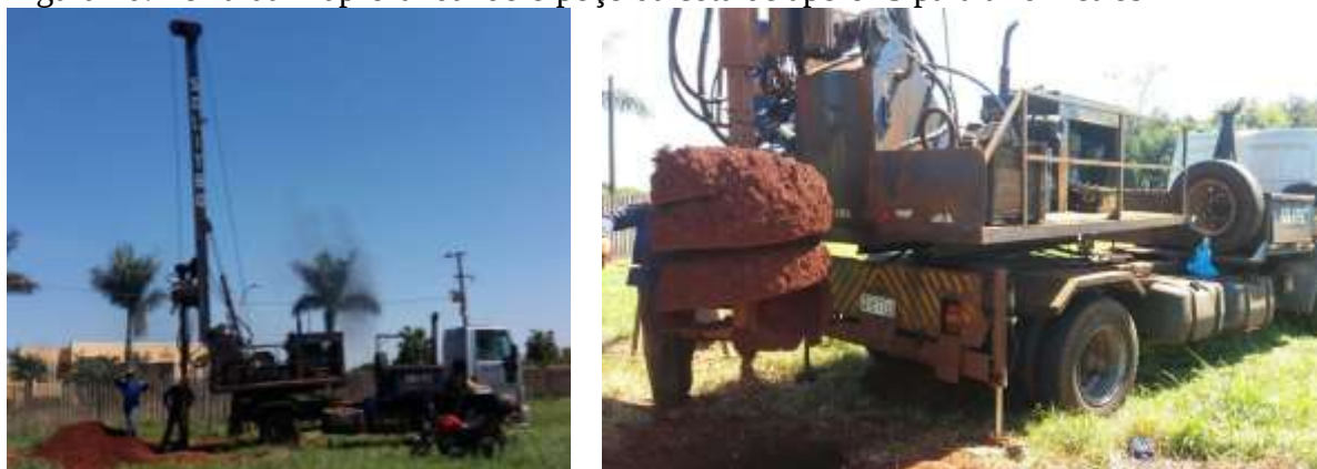
Figura 10: Perfuratriz aprofundando o poço da cota de apoio -5 para a -6 metros
