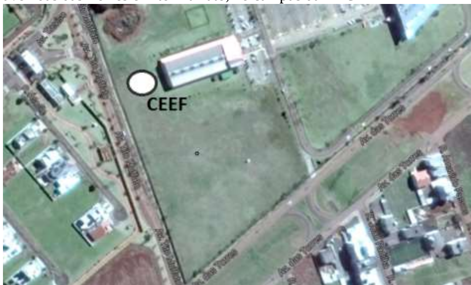
Figura 7: Campo Experimental de Engenharia e Geotécnica da FAG, localizado entre as avenidas das Torres e Tito Muffato, no campus da FAG
