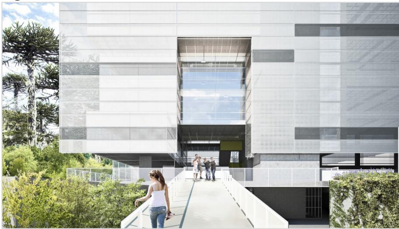
Figura 08 – Membrana têxtil da fachada ventilada.
